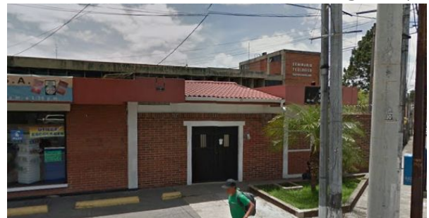
Figura 122. Ingreso SETECA desde Av. Bolívar, zona 3. Fuente: Google Maps
