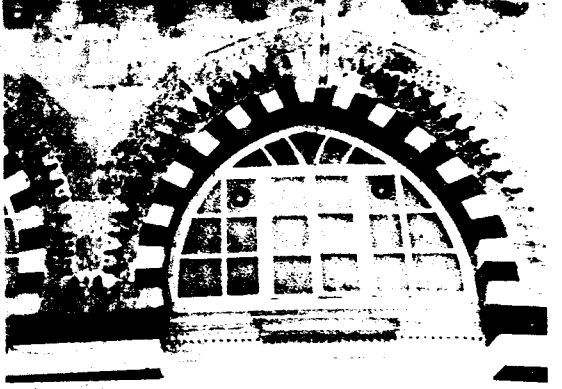
RESİM: 7 Harım cephesindeki kemerlerden detay
