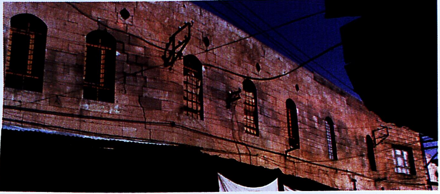
Resim 44: Şark İşhanı batı cephe.
