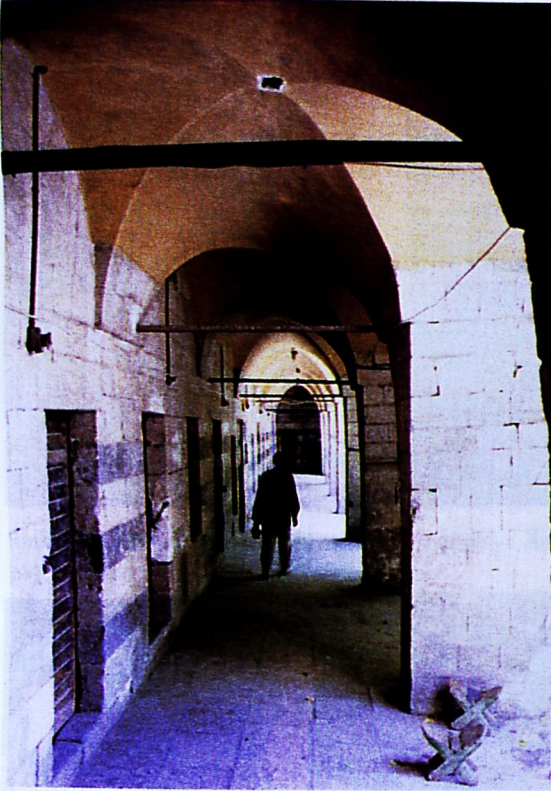
Resim 13: Gümrük Hanı birinci kat revakı.
