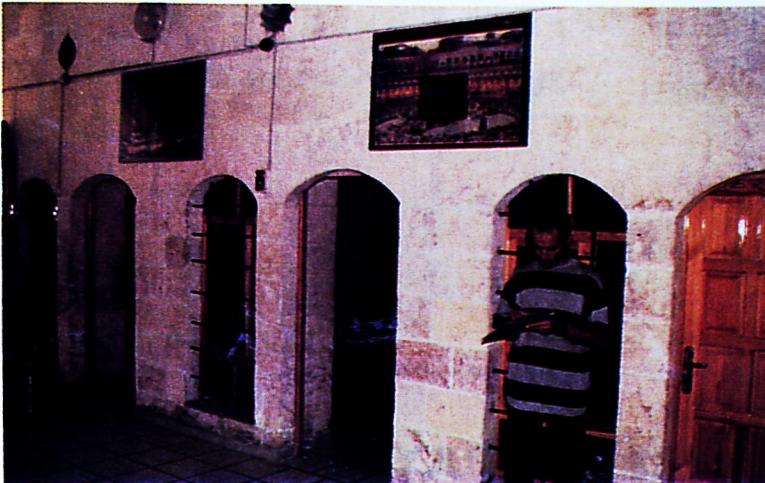
Resim 48: Şark İşhanı zemin kat avlu kuzey kanadı.
