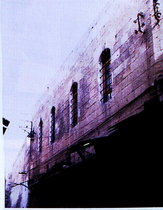
Resim 43: Şark İşhanı kuzey cephe.
