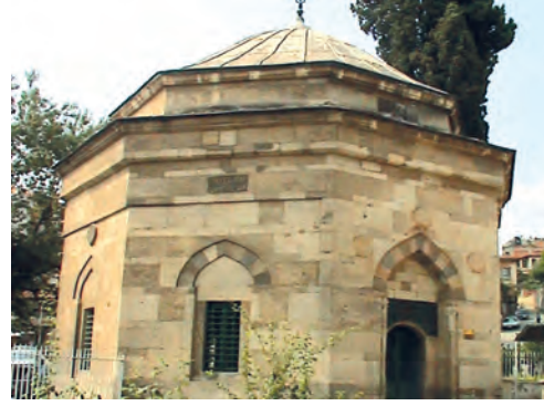
b- Kuzeydoğu Cephesi [Fot: İsmet Çalık]
