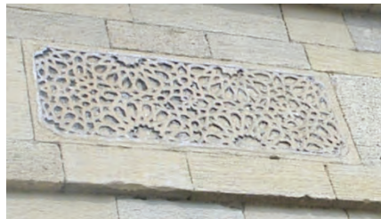
k- Güneydoğu cephesi
