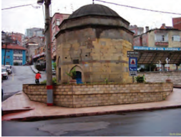
a- Kuzey Cephesi
