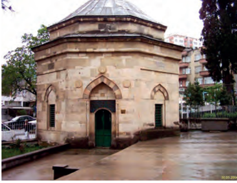
a- Kuzey Cephesi
