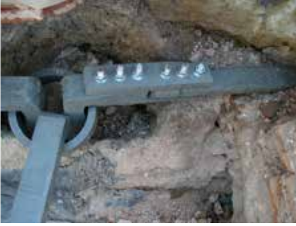
Fotoğraf 42. Yeni gergi sistemi birleşim detayı
