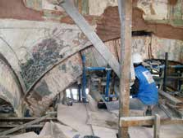
Fotoğraf 73. Ayrılmış kemer parçasının krika sistemiyle kaldırılması
