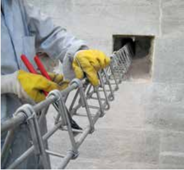
Fotoğraf 10. Paslanmaz çelik donatı uygulaması
