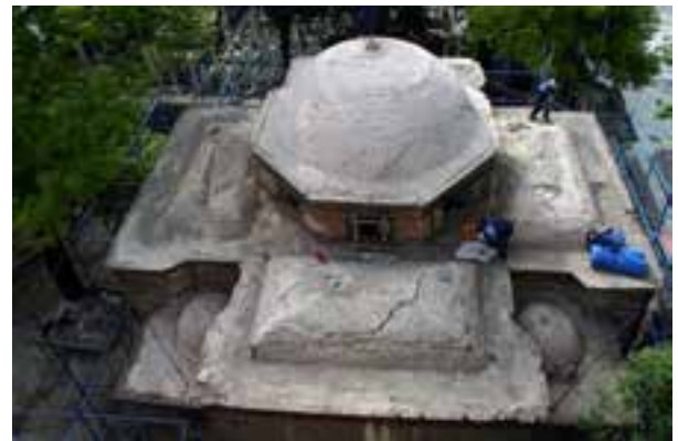
Fotoğraf 59. Tonozları çevreleyen ahşap hatıl sistemi
