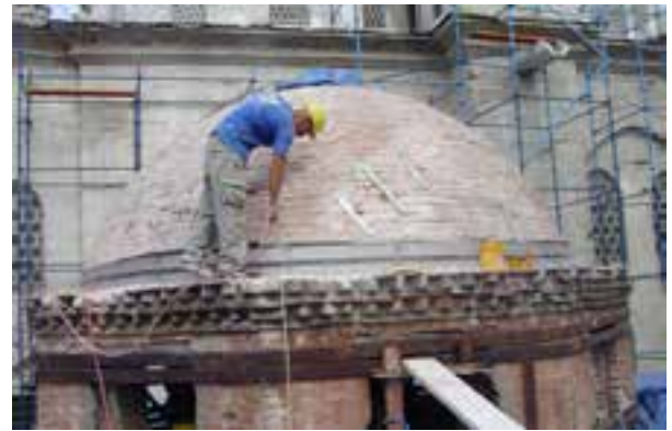
Fotoğraf 58. Paslanmaz çelik kuşaklama uygulaması
