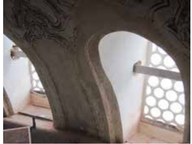
Fotoğraf 51. Yenilenen ahşaplar ve paslanmaz çelik lamalarla takviye edilen hatıl sistemi
