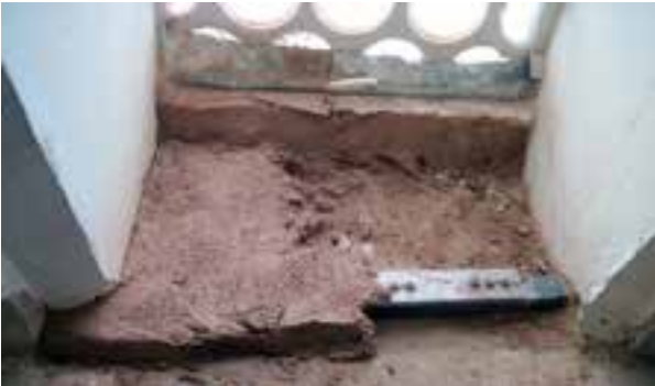
Fotoğraf 47. Hatıl sisteminde bulunlu birleşimlerle takviye yapılması, etrafının horasan harcıyla doldurulması
