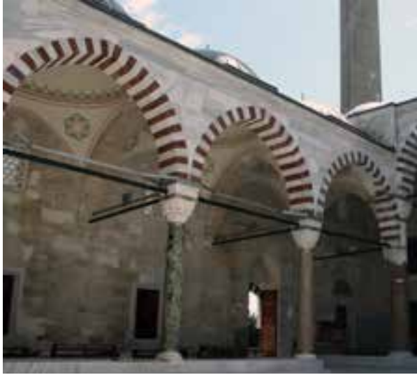
Fotoğraf 18. Revaklı avludaki takviyeli gergi sistemi
