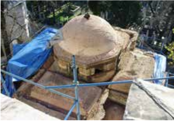
Fotoğraf 60. Tonozları çevreleyen ahşap hatıl sistemi
