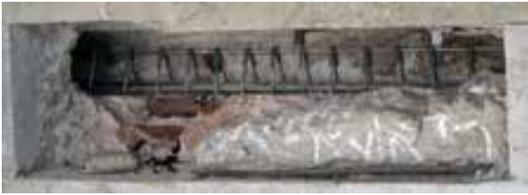
Fotoğraf 11. Paslanmaz çelik donatı uygulaması
