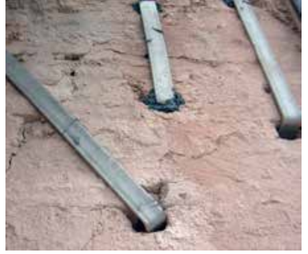
Fotoğraf 24. Paslanmaz çelik kenetlerle çatlak onarımı
