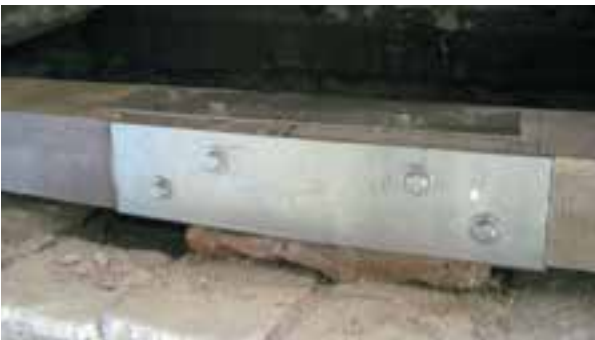
Fotoğraf 71. Takviyeli yeni ahşap hatlı sistemi
