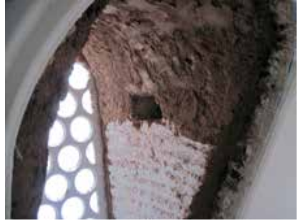
Fotoğraf 50. İşlevini yitirmiş ahşap hatıl boşlukları
