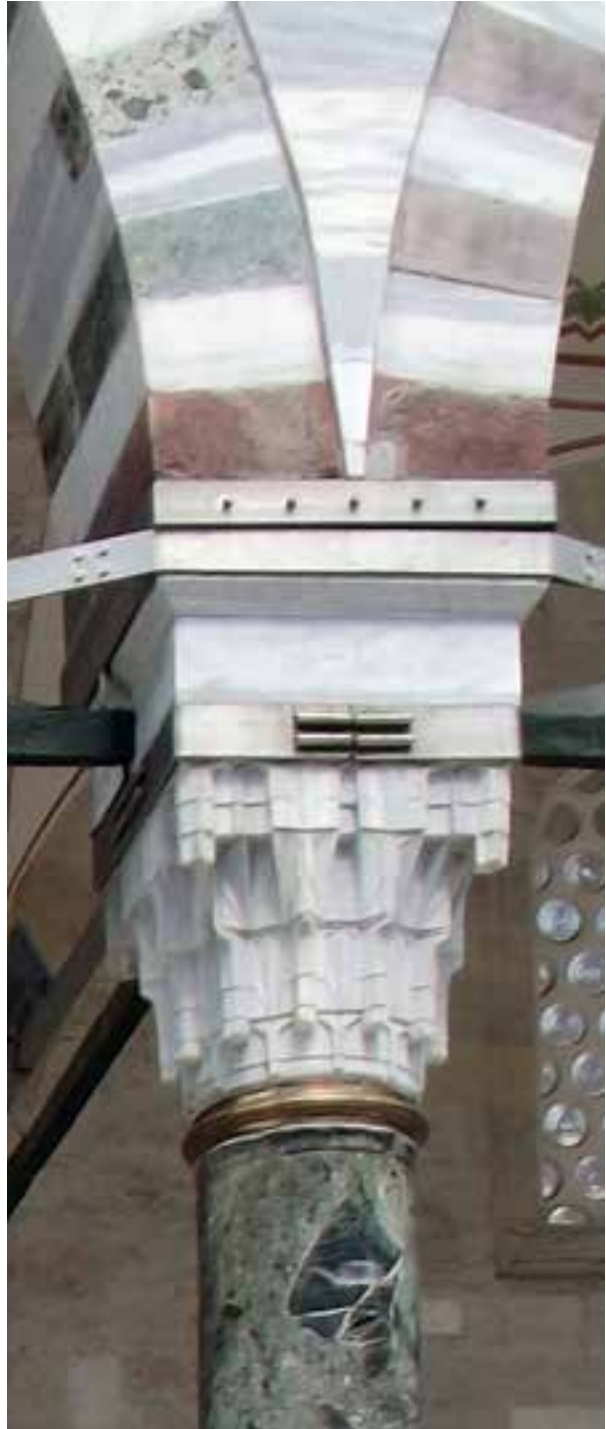
Fotoğraf 15. Paslanmaz çelikten sütun başlığı kuşaklama detayı
