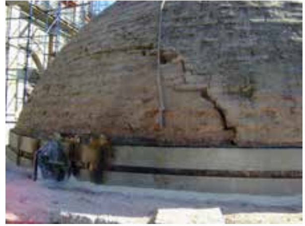
Fotoğraf 55. Paslanmaz çelik kuşaklama uygulaması
