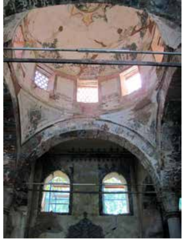
Fotoğraf 78. Paslanmaz çelik gergi sistemi (Askıya alma elemanları söküldükten sonra)
