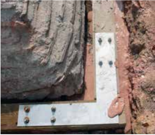
Fotoğraf 61-62. Tonozların çevresinde ahşap hatıl sistemi uygulama detayları
