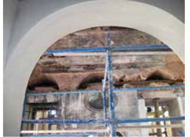
Fotoğraf 68. Pencere üst kotundan geçen ahşap hatlı
