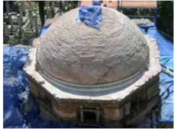
Fotoğraf 56. Paslanmaz çelik kuşaklama uygulaması
