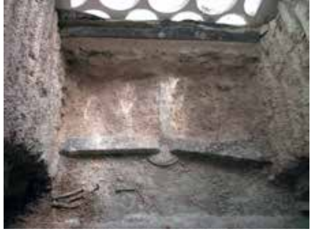
Fotoğraf 44. İçlik dışlık arası tabanında demir hatıl sistemi
