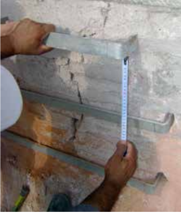
Fotoğraf 23. Paslanmaz çelik kenetlerle orta genişlikte çatlak onarımı
