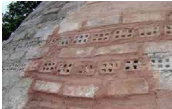
Fotoğraf 36. Kubbe çatlak onarımı dıştan görünüm
