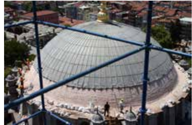
Fotoğraf 19. Ana kubbede çatlak onarımı
