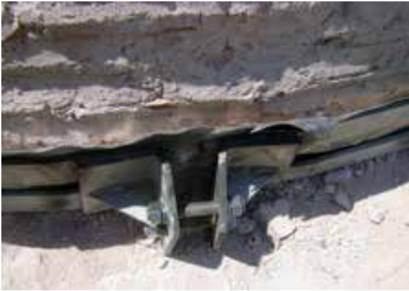
Fotoğraf 57. Paslanmaz çelik kuşaklama uygulaması
