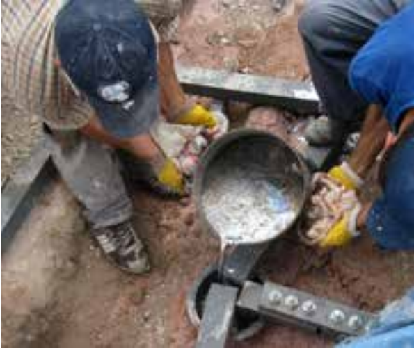
Fotoğraf 43. Erimiş kurşunun birleşim noktasına dökülmesi
