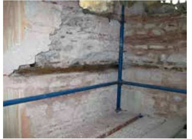
Fotoğraf 70. Özelliğini yitirmiş ahşap hatlı sistemi
