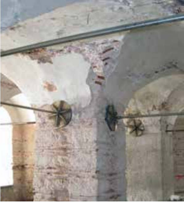
Fotoğraf 81. Bodrum kat paslanmaz çelik gergi sistemi
