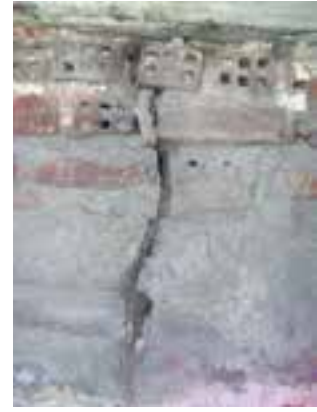
Fotoğraf 32-33. Revaklı avlu köşe kubbesindeki büyük çatlak ve yarıklar
