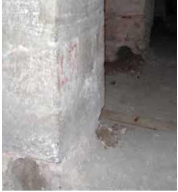
Fotoğraf 82. Bodrum kat ahşap hatil boşlukları
