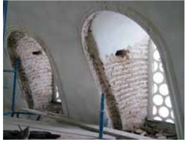
Fotoğraf 49. İşlevini yitirmiş ahşap hatıl boşlukları
