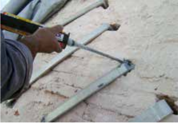
Fotoğraf 25. Paslanmaz çelik kenetlerle çatlak onarımı
