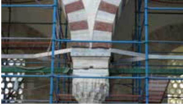
Fotoğraf 17. Kemerlere takviye gergi uygulaması
