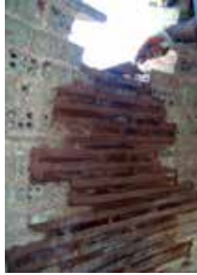
Fotoğraf 34-35. Çatlak hattı boyunca çürütme yöntemiyle kubbedeki çatlak onarımı
