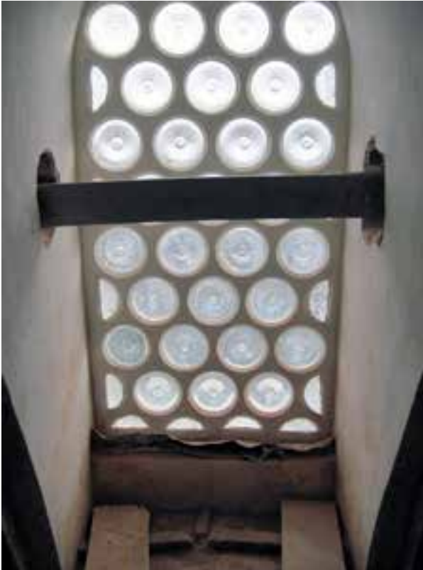
Fotoğraf 52. Yenilenen ahşaplar ve paslanmaz çelik lamalarla takviye edilen hatıl sistemi
