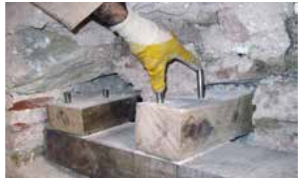
Fotoğraf 72. Takviyeli yeni ahşap hatlı sistemi
