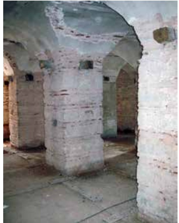
Fotoğraf 80. Bodrum kattaki özelliğini yitirmiş ahşap gergiler
