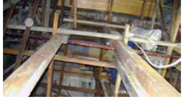
Fotoğraf 66. Kriko sistemiyle tonzun kaldırılması
