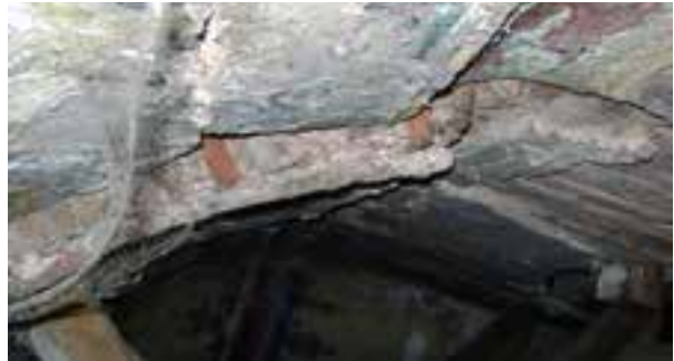
Fotoğraf 64. Çöken tonozun içten görünümü
