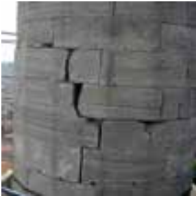
Fotoğraf 1-2. Minaredeki farklı genişliklerde ayrılmalar
