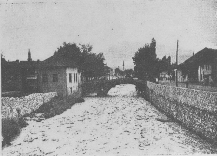
Res. 43 — Prizren'de köprü. (Foto: R. D.)
