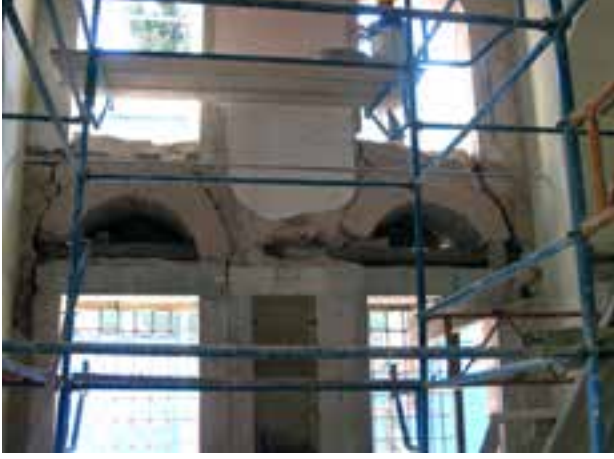
Fotoğraf 21-22. Zemin kat pencere üstlerinde yapılan ahşap hatıl sistemi ve birleşim detayı
