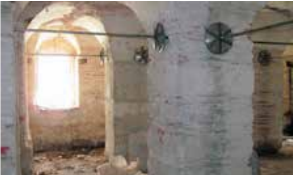
Fotoğraf 20. Bodrum kat payelerinde yapılan paslanmaz çelik gergi sistemi
