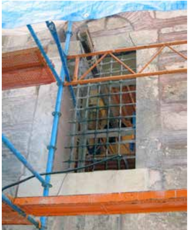
Fotoğraf 44-45. Ayrılmanın izlerinin onarımı
