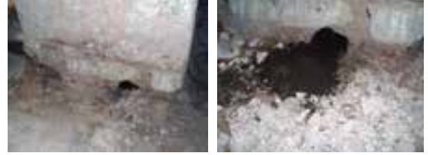
Fotoğraf 10-11. Paye altlarında ahşap hatıl yuvaları ve toz halinde ahşap hatıllar
