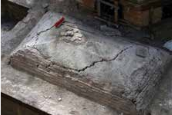
Fotoğraf 37. Tonoz üzerinde çökme
