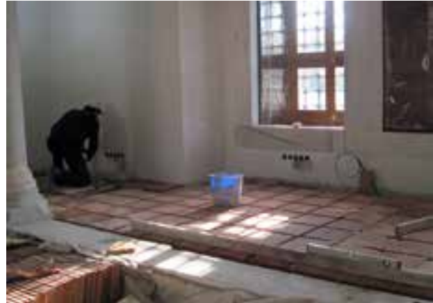
Fotoğraf 54-55. Zemin katta tuğla döşeme yapılması
