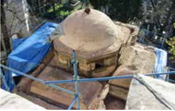
Fotoğraf 17. Üst örtü üzerinde çıkan ahşap hatıl yuvaları
