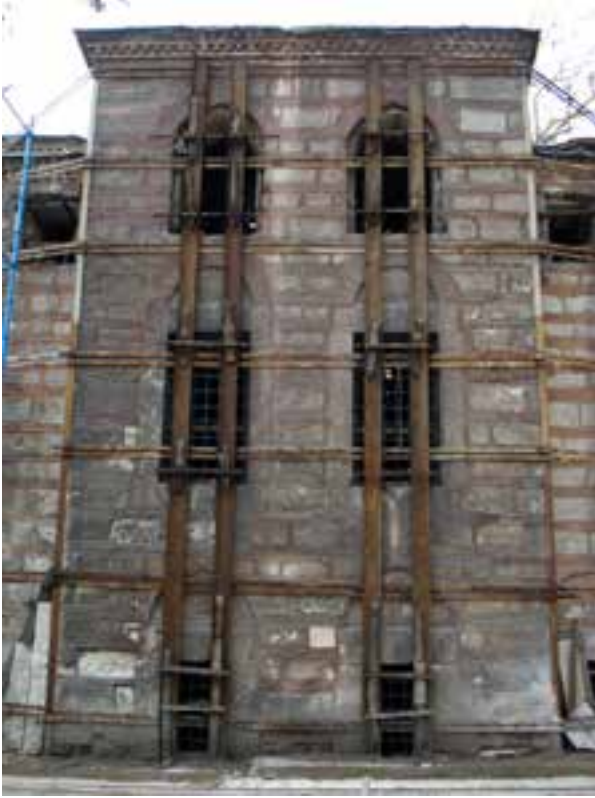
Fotoğraf 9. Kuzeybatı cephesinde demir malzeme ile çemberleme
