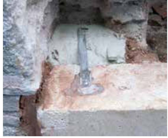
Fotoğraf 40-41. Pencere sövelerine etki eden ayrılmanın izlerinin onarımı
