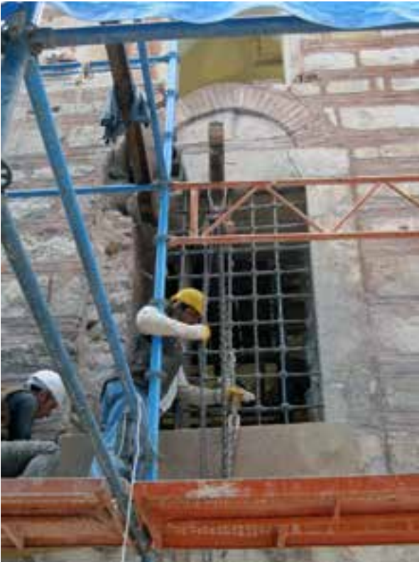
Fotoğraf 44-45. Ayrılmanın izlerinin onarımı
