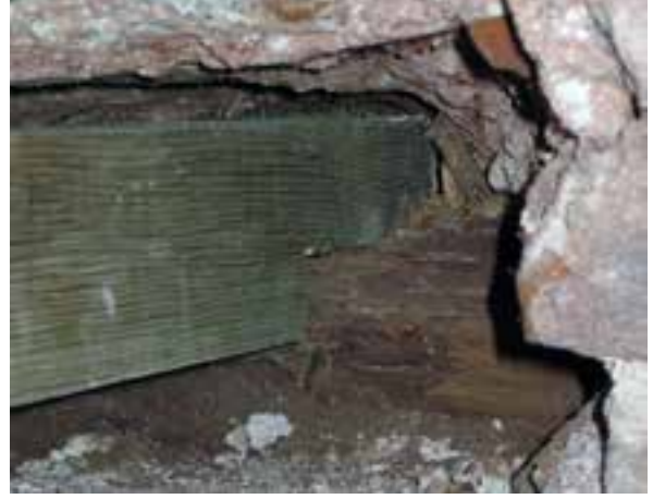
Fotoğraf 23-24. Dışlık penceresi altlarında yapılan ahşap hatıl sistemi ve bindirme detayı
