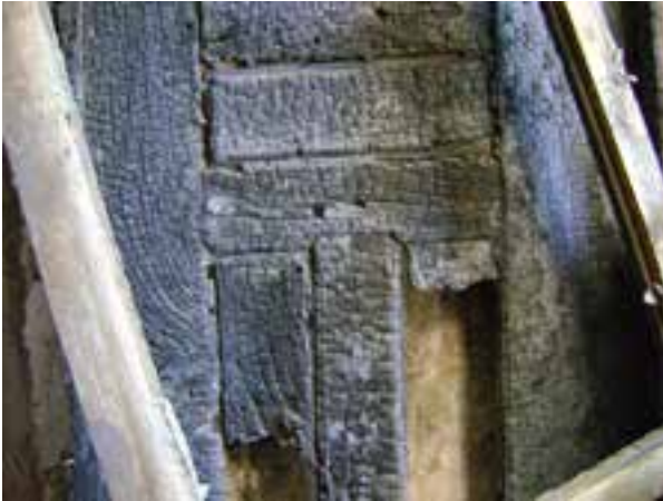
Fotoğraf 61. Yanmış ahşap kepenk
