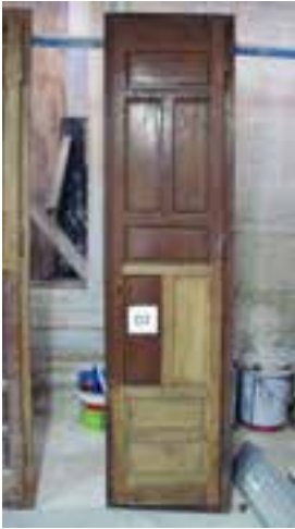
Fotoğraf 64-65. Ahşap kepenler üzerinden mevcut cilanın çıkarılması
