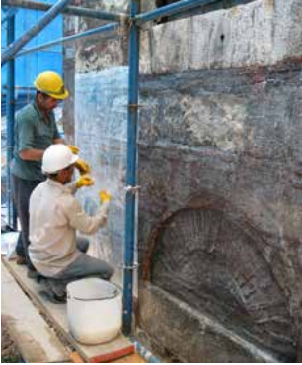
Fotoğraf 52-53. Cephelerde AB57 ile temizlik yapılması
