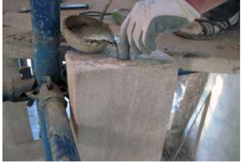
Fotoğraf 42-43. Paslanmaz çelik zvana ile birleştirilen mermer söve
