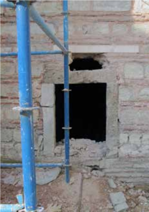
Fotoğraf 50-51. Hasarlı taşların değiştirilmesi
