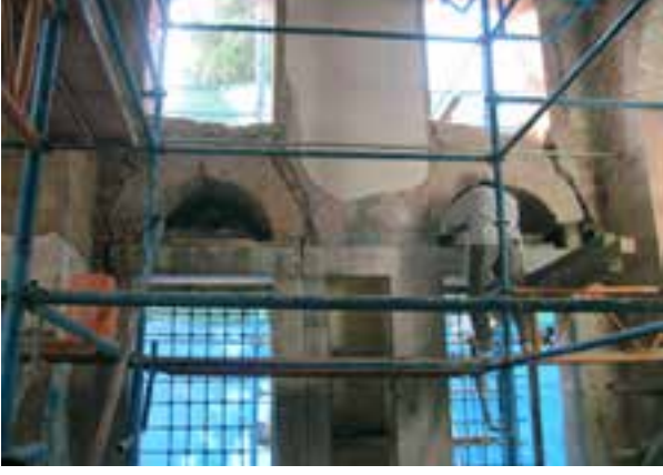
Fotoğraf 14. Zemin kat pencere üstlerinde ahşap hatıllar
