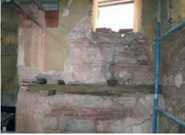
Fotoğraf 23-24. Dışlık penceresi altlarında yapılan ahşap hatıl sistemi ve bindirme detayı
