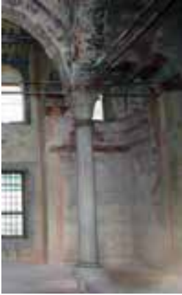
Fotoğraf 58-59. Mermer sütunlarda AB57 ile temizlik yapılması
