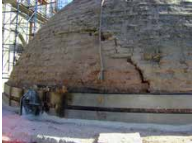
Fotoğraf 31-32. Merkezi kubbe eteğinde çemberleme sistemi
