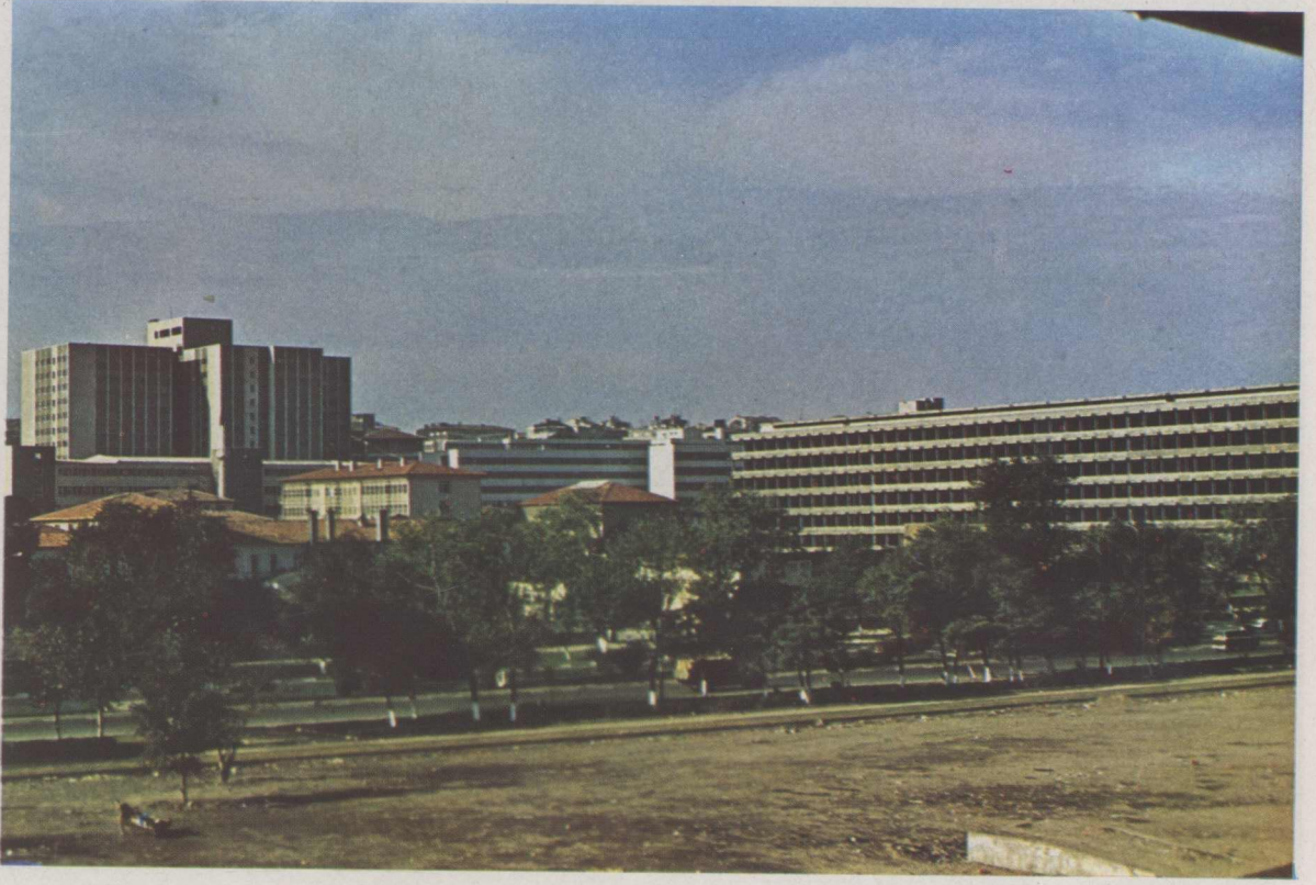
Vakıf Guraba Hastahanesi ve sađda yeni yapılan ek inřaatı.
