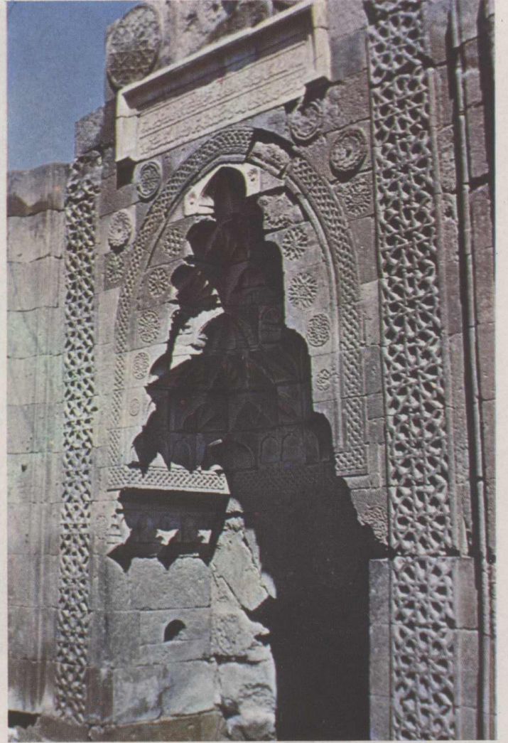
Kayseri, Gevher Nesibe Hatun Şifahanesi portali (Foto: ODTÜ-3504)
