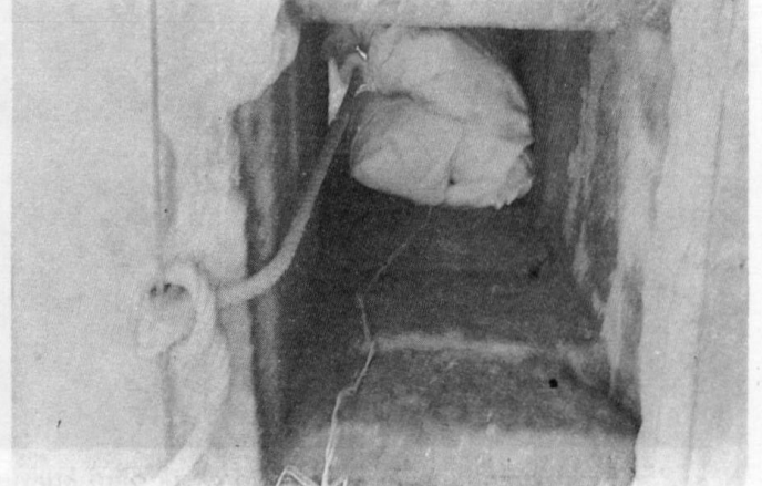
Res. 30-31: Şadırvan avlusunun döşemesinde bulunan bir roğardan içeriye girilerek, cami altında mevcut eski su yolu ve drenaj sisteminin galerileri bulunmuştur. Restorasyonları devam etmektedir.
