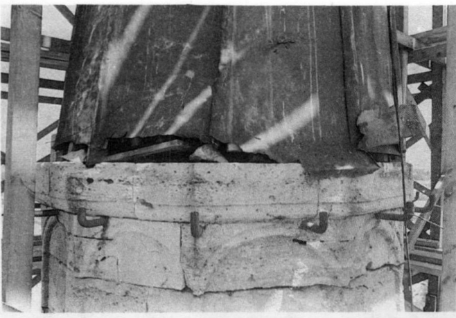
Res. 28: Batı minaresinin külah ve peteğinin restorasyon öncesi görünüşü.
