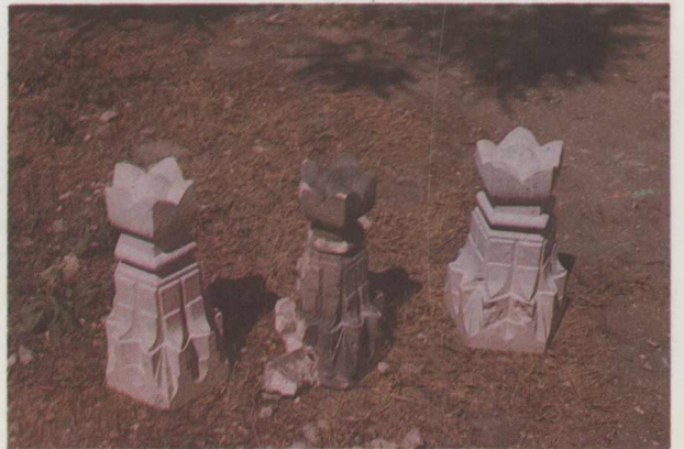
Resim 11: Şerefe altı püsküllerinin bozuk olanları yeniden imal edildi.
