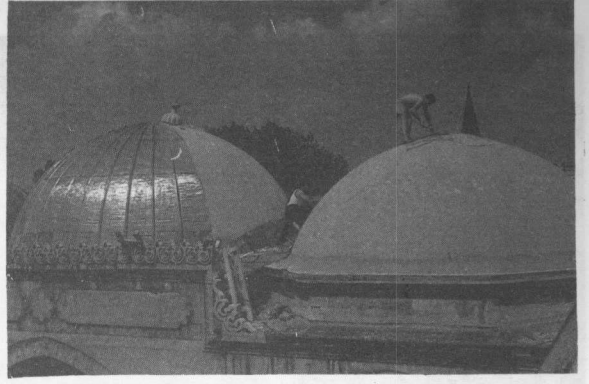
Res. 5: Şadırvan avlusu kubbeleri kurşun kaplanmıştır.
