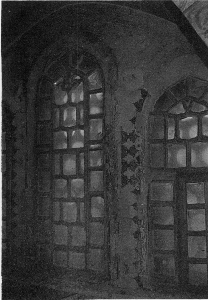
Res. 32: Pencere çevresinde raspalar neticesi bulunan klasik dönem nakışları.
