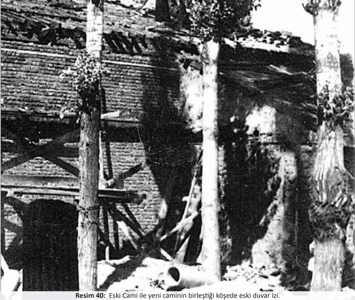
Resim 40: Eski Cami ile yeni caminin birleştiği köşede eski duvar izi.
