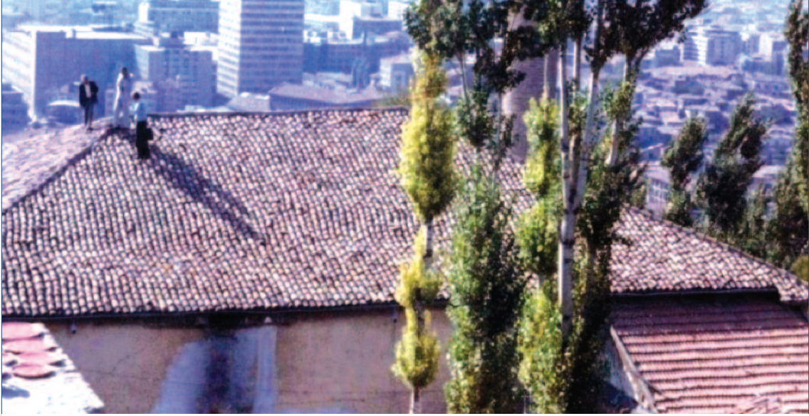
Resim 18: Caminin 1984 tamiri öncesinde doğu cephesi (VGM Arşivi).
