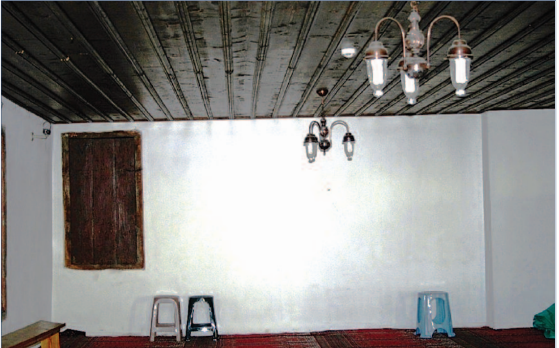
Resim 39: Kadınlar mahfelinin içinden doğudaki duvarda çatıya açılan kapı.
