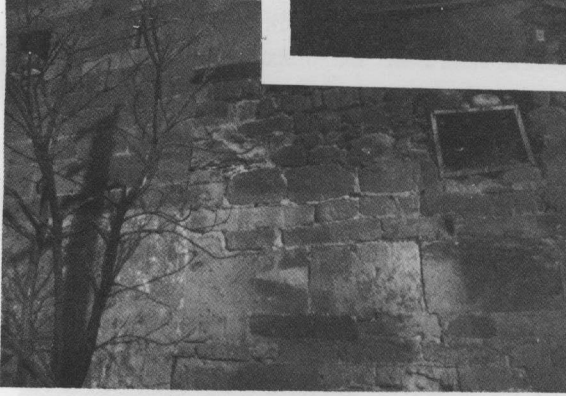
Resim 31- İki kısmın birleřtiđi yerdeki silme ve dilatasyon (Güney)
