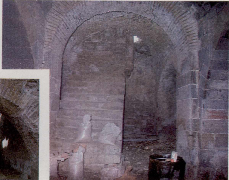
Resim-17 Merdivenin Ön Görünüşü
