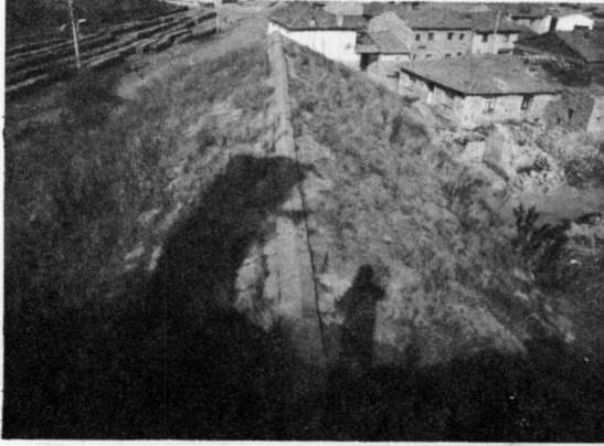
Resim 3- develik kısmı çatı örtüsü
