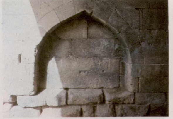
Resim-5 Giriş Eyvanındaki Teğet Kemerli Niş
