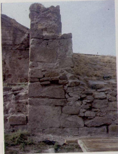
Resim-33 Dilatasyonun Kuzey Cephesinden Görünüşü, Detay.
