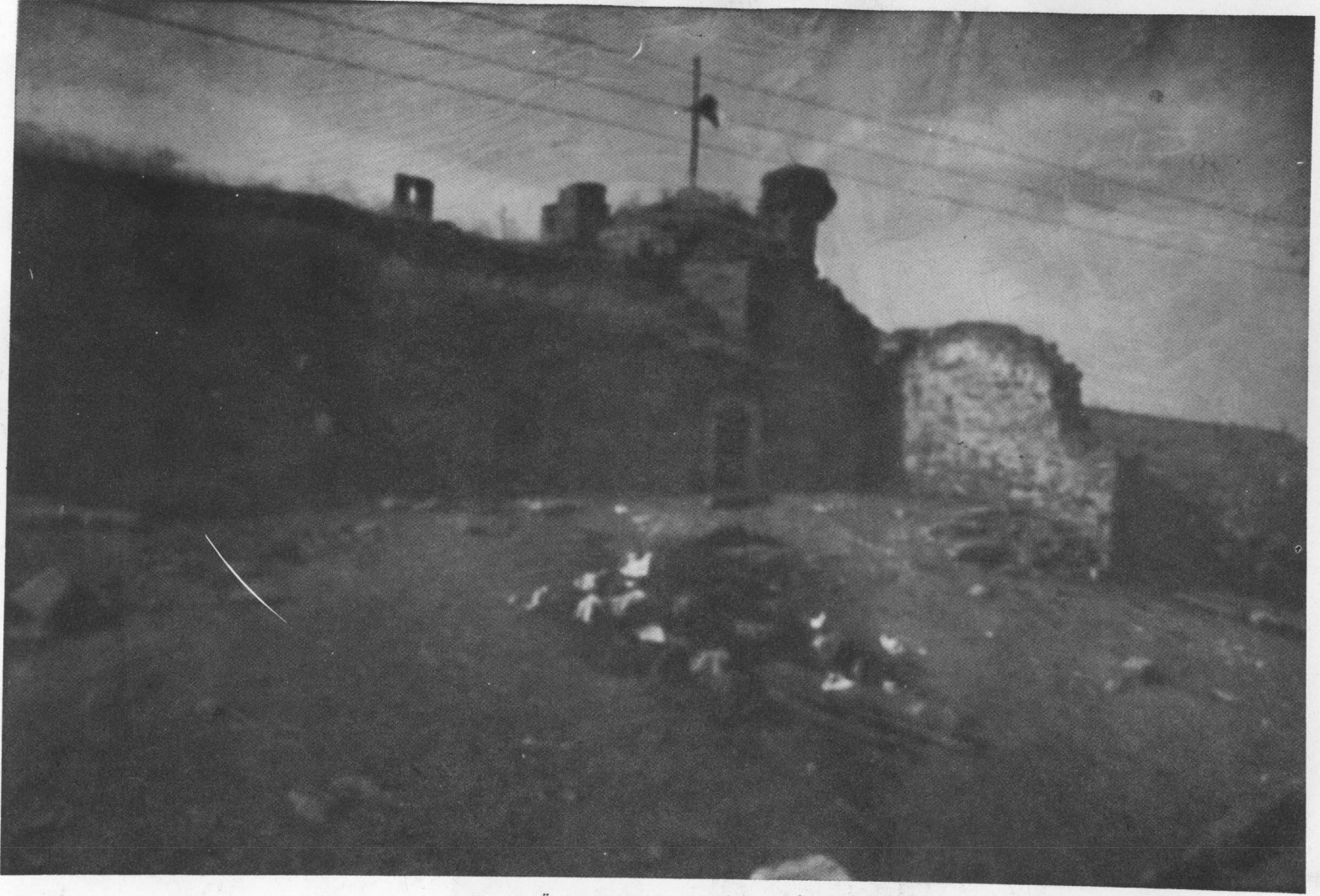
Resim 18- Üst katın koridorunun batı tarafının görünüşü
