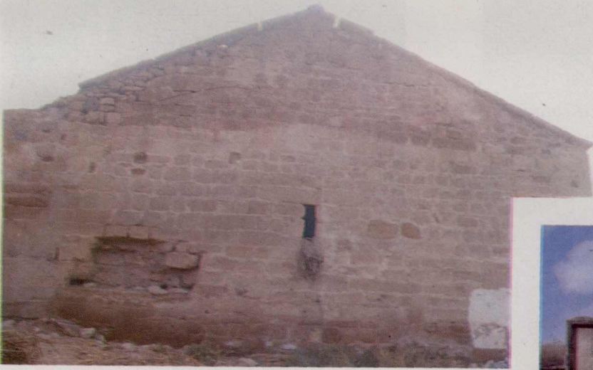
Resim-2 Develik Kısmı Batı Cephesi
