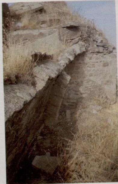
Resim-30 Mescid ve Bitisik Odanın Üstünde Bulunan Yarım Tonoz ve Yarım Takviye Kemer
