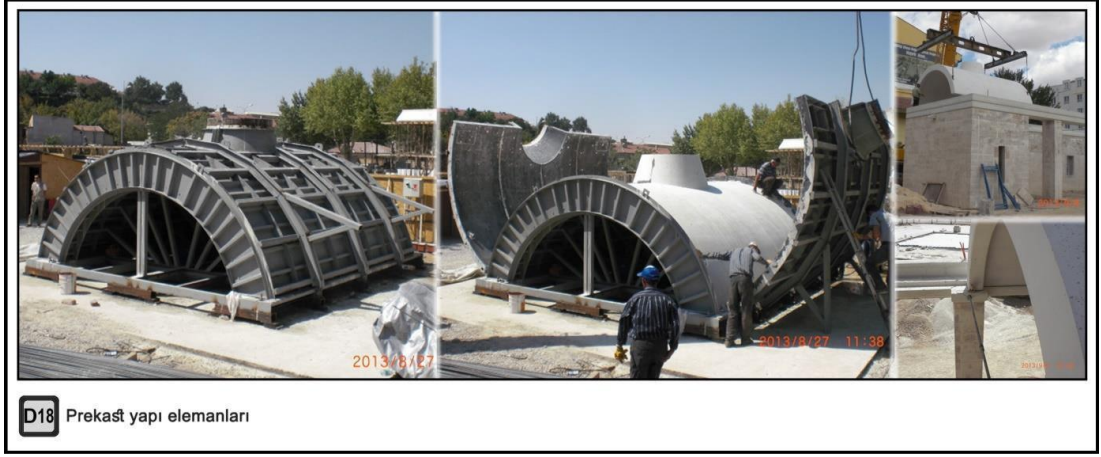
Şekil 3.19: Prekast tonozların imalatı ve yerleştirilmesi
