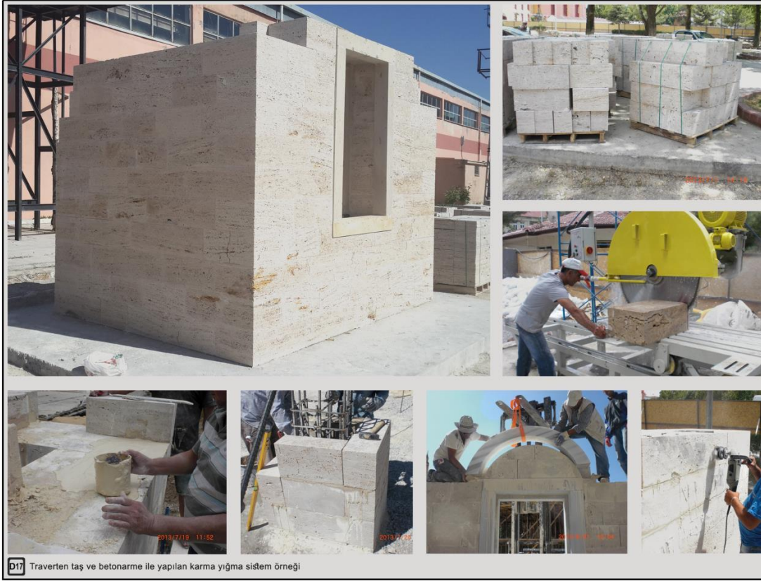
Şekil 3.18: Traverten taşlar ve betonarme ile yapılan karma yığma duvar örnekleri
