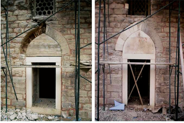
Fotoğraf 23. İmaret Batı cephesi: Taş çürütme sonrasında sağlamlaştırma işlemi, 2011 (Ebru Sünnetçi)
