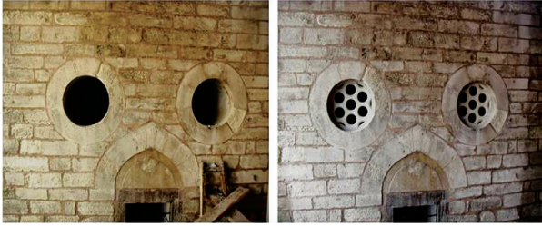
Fotoğraf 22. Darrüşifa: Tepe penceresi bütünleme işlemi, 2011 (Ebru Sünnetçi)
