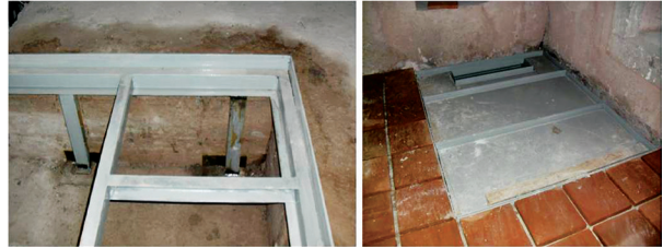
Fotoğraf 26. Döşeme altına tesisat yerleştirilmesi, 2011 (Ebru Sünnetçi)
