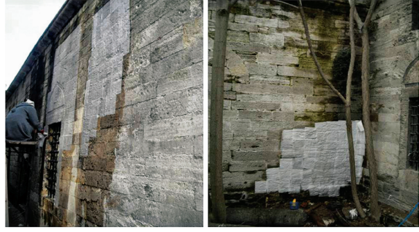
Fotoğraf 18. Darrüşifa cephelerinde kimyasal temizlik çalışmaları, 2011 (Ebru Sünnetçi)
