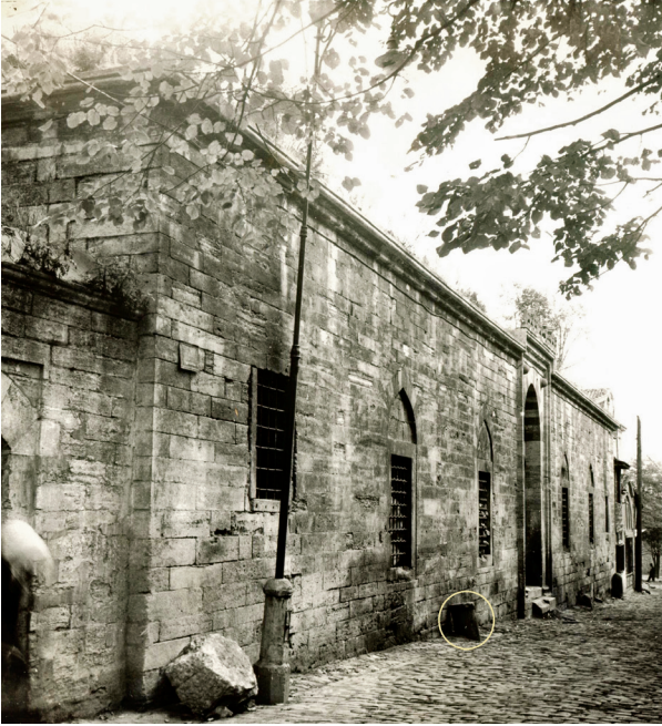
Fotoğraf 5. Medresesinin Haseki Caddesi cephesi (Vakıflar Arşivi, 1960 onarım dosyası)
