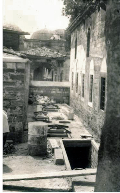
Fotoğraf 14. Medrese ile Avrat Pazarı Dükkanı ile arasındaki, bodrum katta servis mekanları inşaatı, 1968 (Vakıflar Arşivi)
