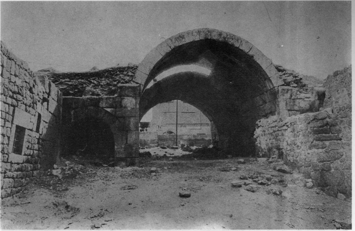
Resim 1: Aulunun güney cephesinden görünüş (istimlak öncesi).
