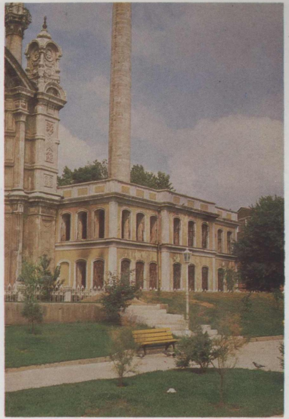
Resim 2: Sol taraf hünkar kasrının restorasyon öncesi görünüşü (cami batı cephesi ile birlikte)
