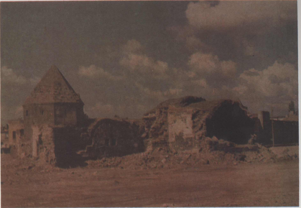
Resim 3: Medrese kalıntılarının güneyden görünüşü (istimlak sonrası).
