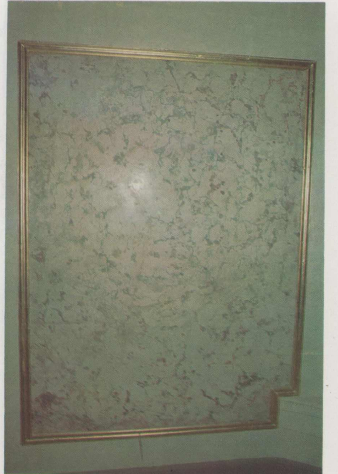
Resim 14: Hünkar mahfelinde yangından tahrip olmuş stuk yüzeyin onarım sonrası görünüşü.
