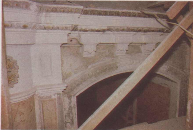
Resim 20: Cami ana mekanında mahfel çevresi kemerlerde alçı profillerin onarımının görünüşü.
