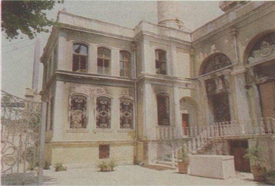
Resim 3: Cami giriş cephesinin restorasyon öncesi görünüşü.
