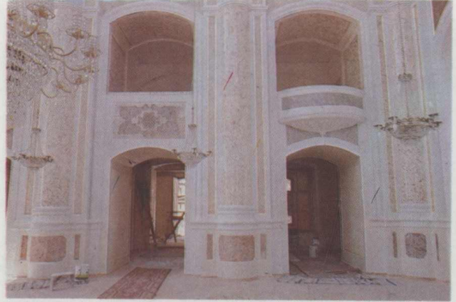
Resim18: Cami ana mekanı kuzey cephesinin restorasyon sonrası görünüşü.
