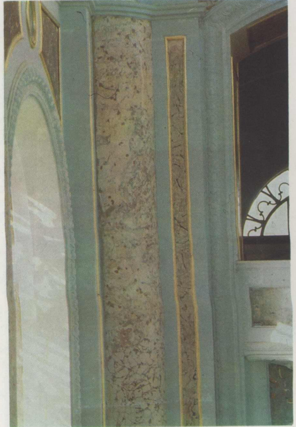
Resim17: Cami ana mekanı batı cephesinin restorasyon sonrası görünüşü.
