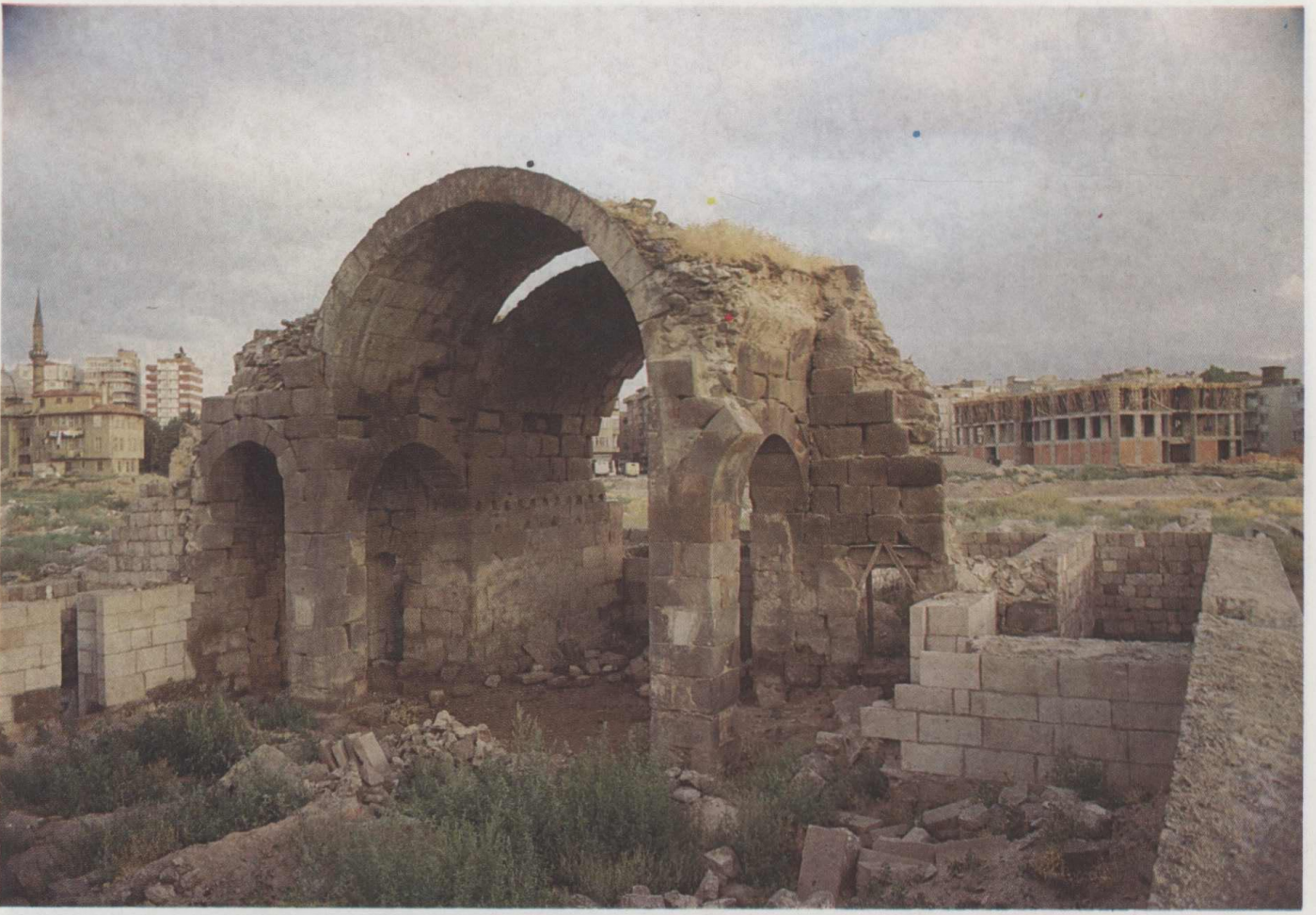
Resim10: Medresenin (avlunun) güneyindeki ana eyvan ile önünde yer alan revaktan görünüş.
