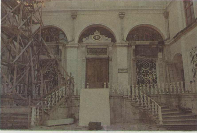
Resim 9: Cami giriş cephesindeki kapı, pencereler ve silmelerdeki onarımların görünüşü.
