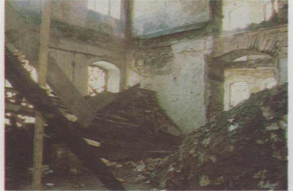
Resim 4: Sol Hünkar Kasrı iç mahallerinin restorasyon öncesi görünüşü
