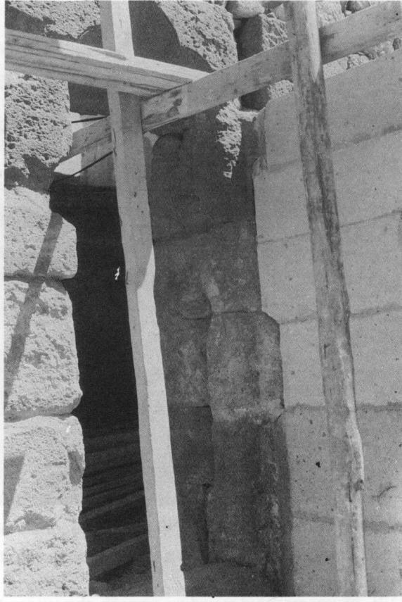
Resim 4: Hücreye ait sövesiz kapı dışının yeni duvarla birlikte görünüşü.
