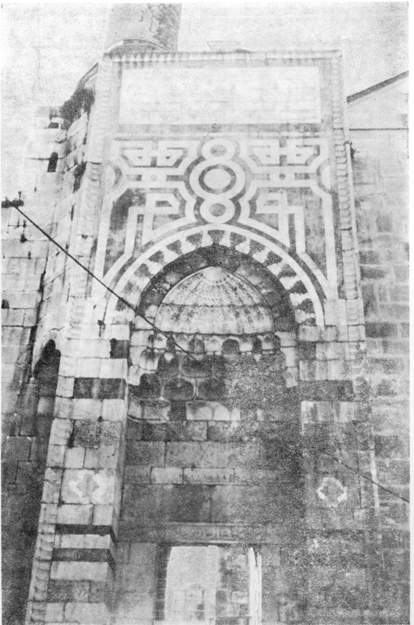
Resim : 18 Selçuk, İsa Bey Camisi, Taçkapı, Onarım sonrası
