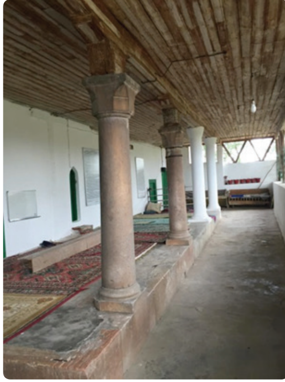
Resim 7. Avluda Bulunan Platform
