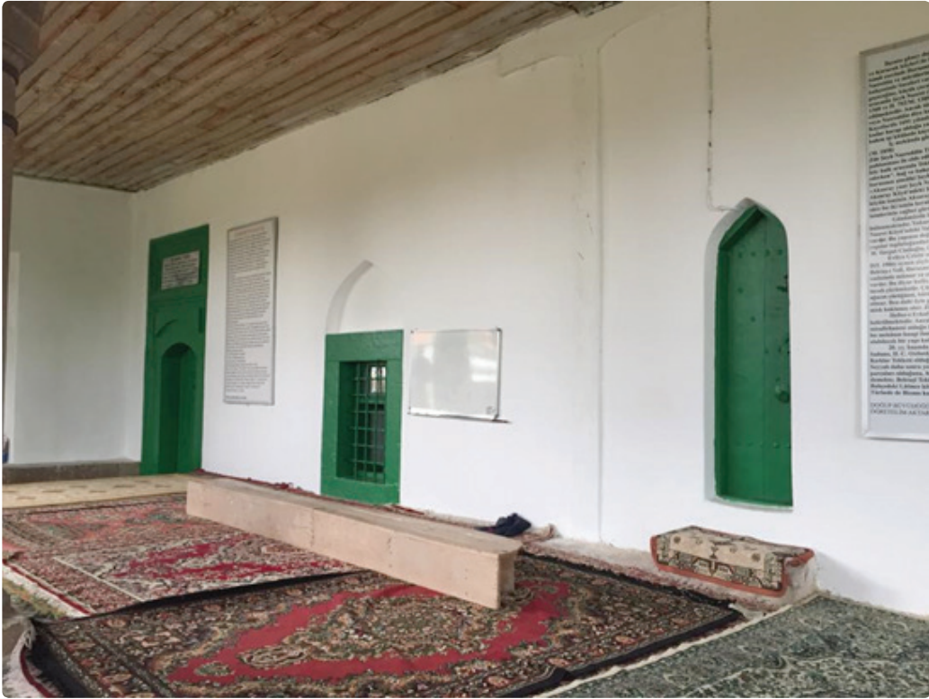
Resim 6. Avlu Güney Duvarı
