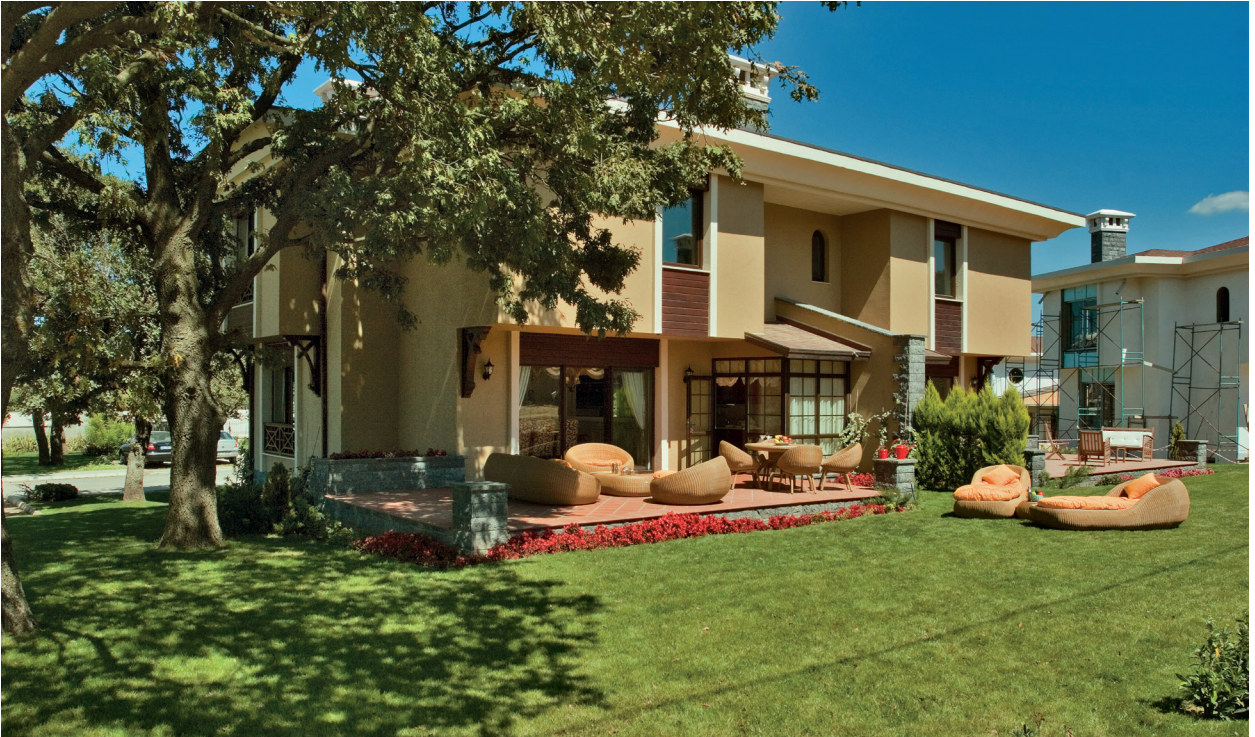
Mimari yapının karşı orta yüksekliğine çıkılmadığı durumlarda fotoğraf makinesinin merceği ekseni yere paralel tutulmalıdır. Bu durumda fotoğrafın alt bölümünde geniş bir boşluk kalacak ancak yapıda deformasyon oluşmayacaktır. Alt bölümde oluşan boşluk istenildiğinde kesilerek fotoğraftan atılabilir ya da bu bölüm renk ya da nesnelere desteklenerek görünürlüğü güçlendirmekte kullanılabilir. (Çekmeköy-İstanbul) Fotoğraf: Yücel Tunca
