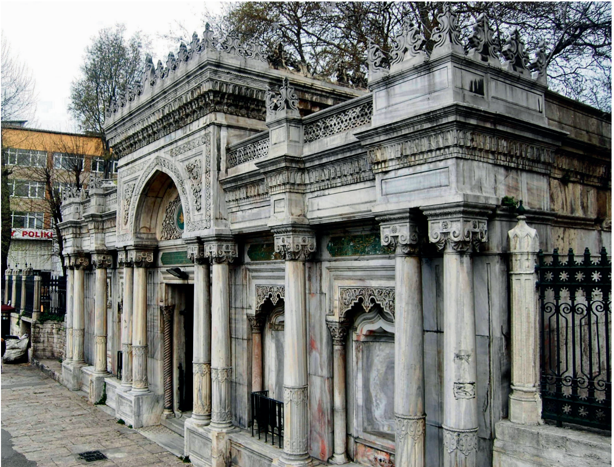
Bir yapının düşey çizgilerinin eğim kazanmadan fotoğflanabilmesinin yollarından biri yapı yüksekliğinin orta noktasından çekim yapmaktır. (Pertevniyal Valide Sultan Camii -İstanbul) Fotoğraf: H.Murat Ceylan
