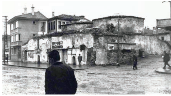
Fotoğraf 5: Tabaklar Hamamı'nın soyunmalık kısmı yandıktan sonraki durumu, güney ve doğu cepheler, İzzet Baysal Caddesi'nden görünüşü, 1964 (?) (VGM arşivi)
