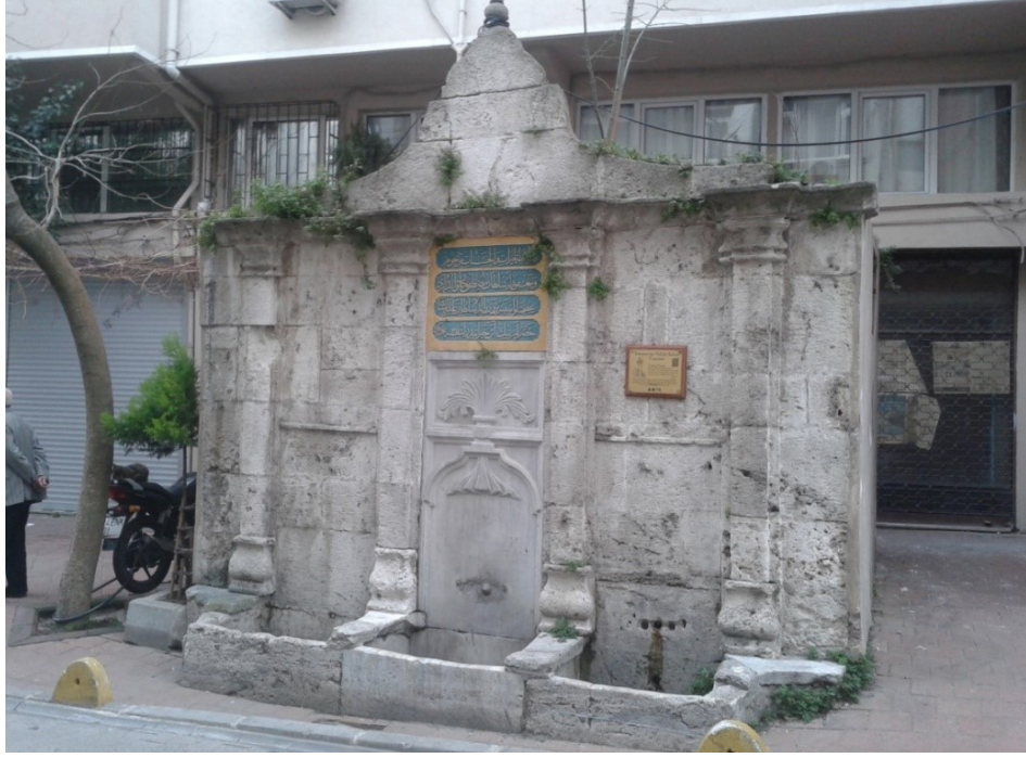
Resim 6.25 Kuzey Cephesi Görünüşü
