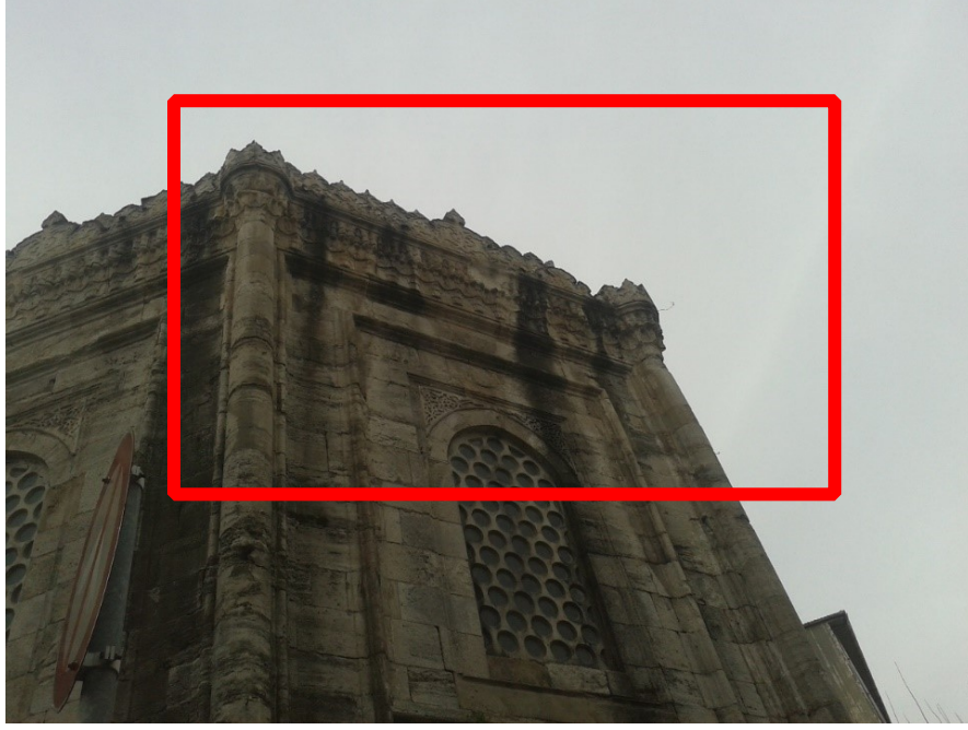
Resim 6.8 Hüsrev Paşa Türbesi Saçak Mukarnaslardaki Erimler ve Dendanlardaki Parça Kopmaları
