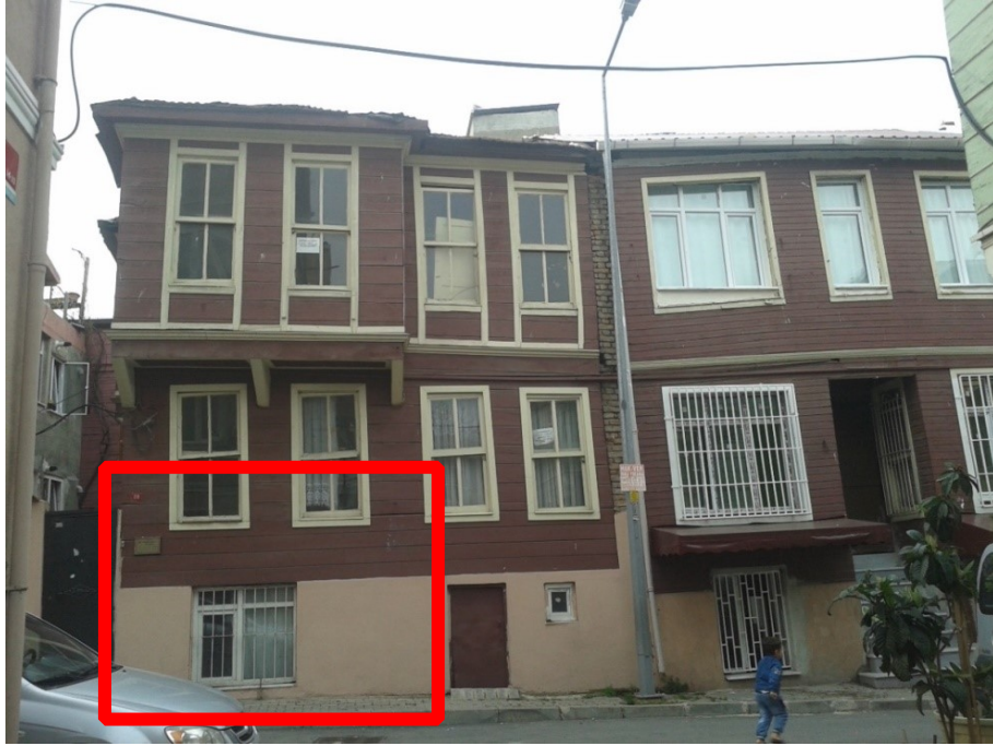
Resim 6.39 Plastik Esaslı Pencere Takılması
