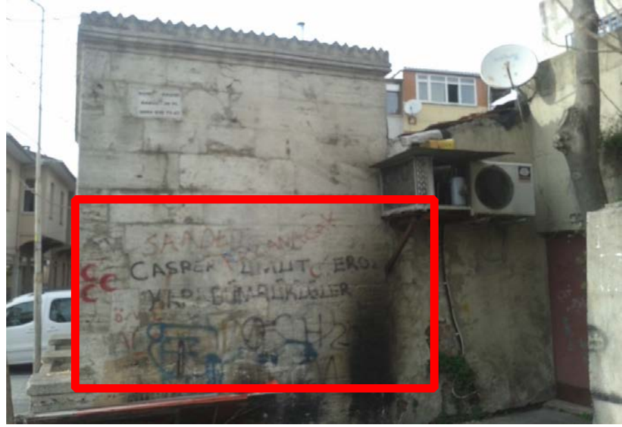
Resim 6.34 Doğu Cephesi Yüzey Kirlenmeleri
