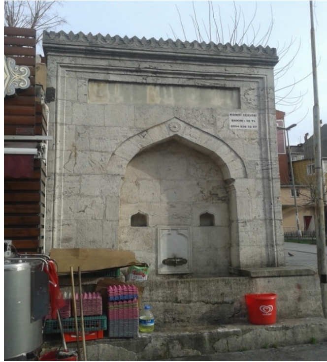
Resim 6.34 Doğu Cephesi Yüzey Kirlenmeleri
