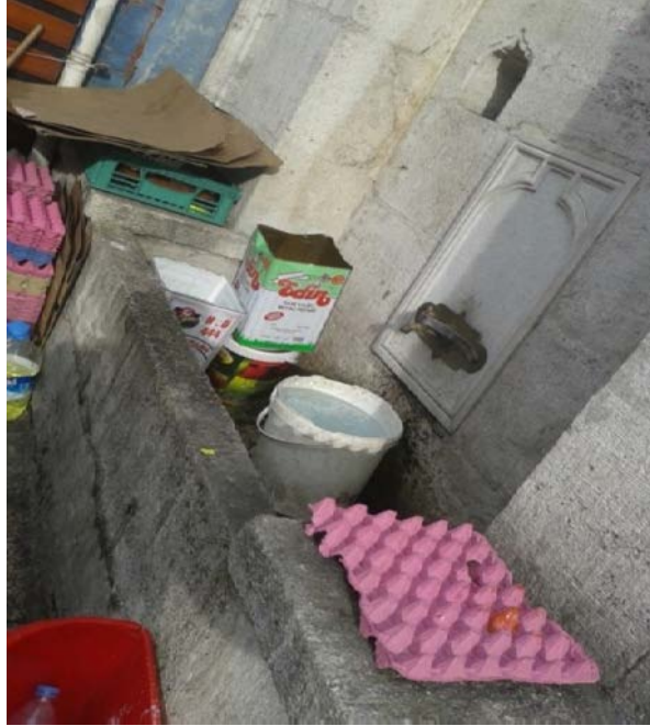
Resim 6.36 Köşelerdeki Yüzey Erimeleri Ve Form Kaybı
