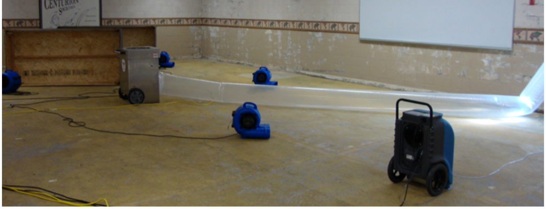
Resim 4.4 Su Hasarlarına Müdahale
