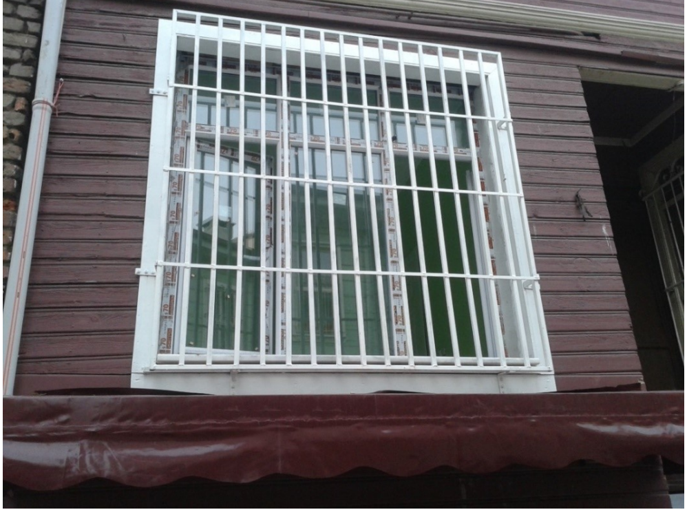
Resim 6.41 Cephe Oranlarının Bozulması
