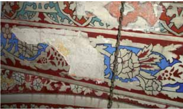
Fotoğraf 13. Cami orijinal sıva yüzeyine (alt tabakada kırmızı renkli) ve onarım sıvası yüzeyine (üst tabakada çok renkli) doğrudan uygulanmış olan bezemeler.
