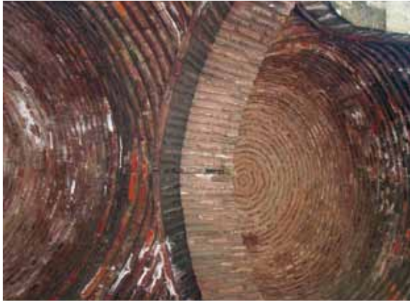
Fotoğraf 10. Kubbelerin genelinde ve revak kemerlerinde kullanılmış olan yaprak tuğla örgü malzemesi.
