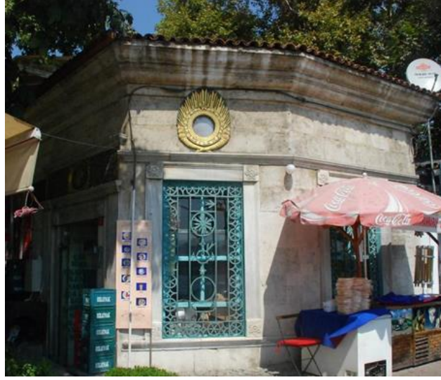
Şekil 3.10 Muvakkithane'nin günümüzdeki durumu.
