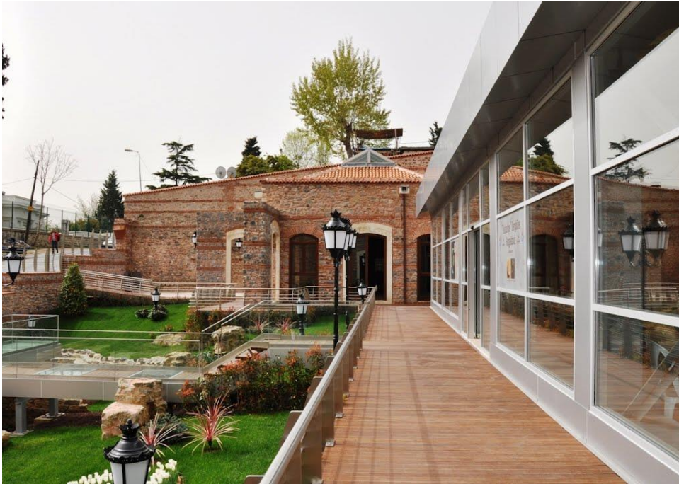
Şekil 3.64 Yapılara girişler (Url-11, 2013).
