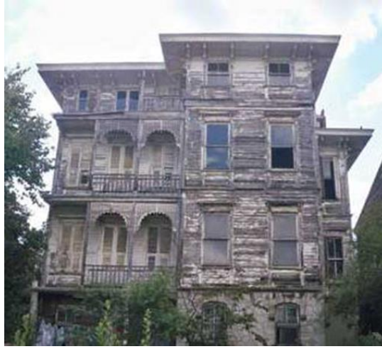
Şekil 3.21 Köşkün restorasyondan önceki durumu (Url-7, 2013).
