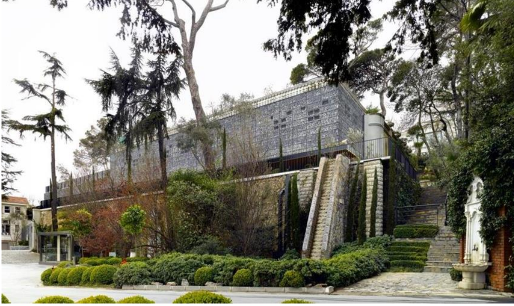
Şekil 3.56 Atlı Köşk bünyesindeki Oditoryum ek binası (Url-12, 2013).
