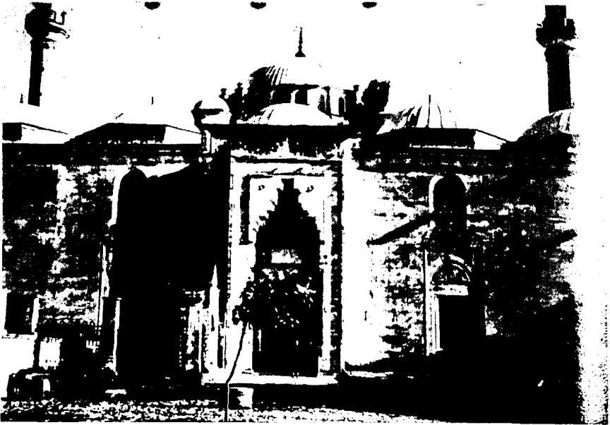
28 — Fatih Camii revaklı avlusunun esas kapı cephesi. Bu cephe pençerelerinin üstlerindeki kemerlerin içi porfir üzerine mermerle kakma olarak nefis sülüs hatla yazılar yazılmıştır. Pençerelerin etrafı kâmilan molürdür.
