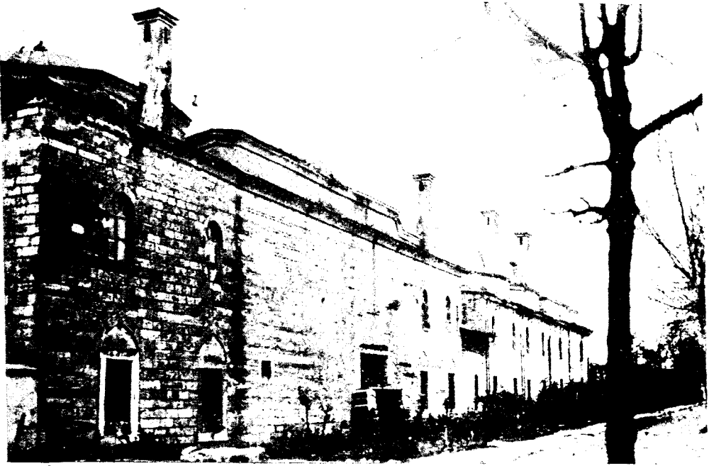
50 — Fatih Camiinin tabhane medresesi yan cephesi. Bu cephe 1767 zelzelesinde harap olduğundan 1771 yılında tamir olunmuştur. Bugün mevcut tadilat ile barok profiller o tamirin hatırasıdır.
