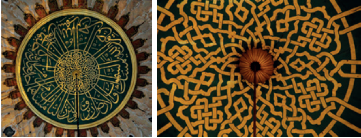
Fotoğraf 1b, c Ana kubbe Restorasyon Sonrası Durum
