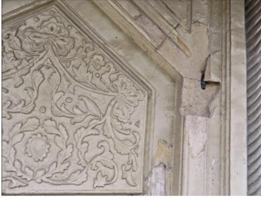
Şekil 2.103. Çeşme üzerinde bulunan kırıklar (Özge Tokur, 2019)
