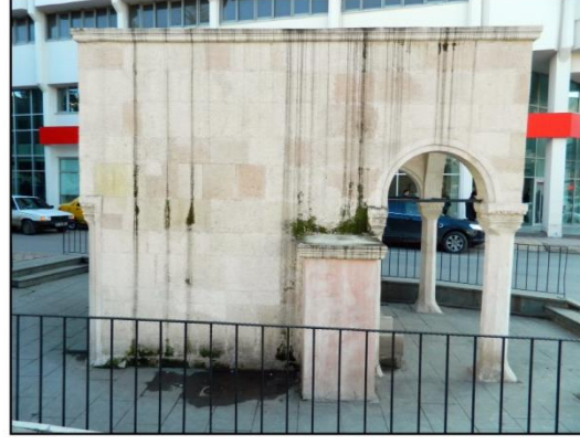
Şekil 2.9. Ali Bey Çeşmesi Batı Cephesi (Özge Tokur, 2019)
