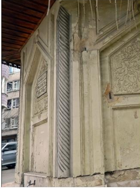
Şekil 2.83. Çeşme cephelerinde bulunan sütunçe (Özge Tokur, 2019)
