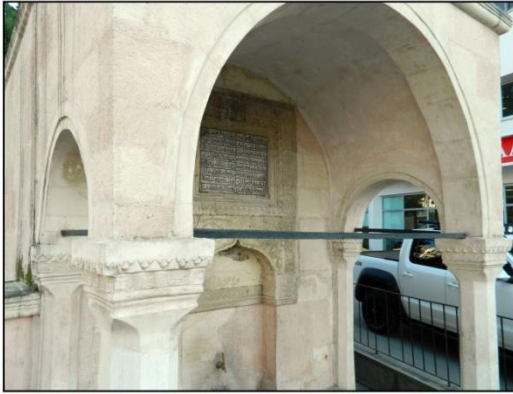
Şekil 2.10. Ali Bey Çeşmesi sekizgen sütunları ve tonozu (Özge Tokur, 2019)
