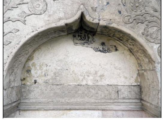
Şekil 2.4. Ali Bey Çeşmesi Güney cephesi alt kitabesi (Özge Tokur, 2019)
