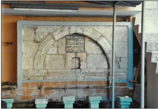
Şekil 2.61. Mescit Çeşmesi 1994 yılı genel görünümü (M. Sami Bayraktar Arşivi f.ç. tarihi: Temmuz 1994)
