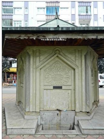
Şekil 2.96. Hüseyin Bey Çeşmesi E cephesi (Özge Tokur, 2019)
