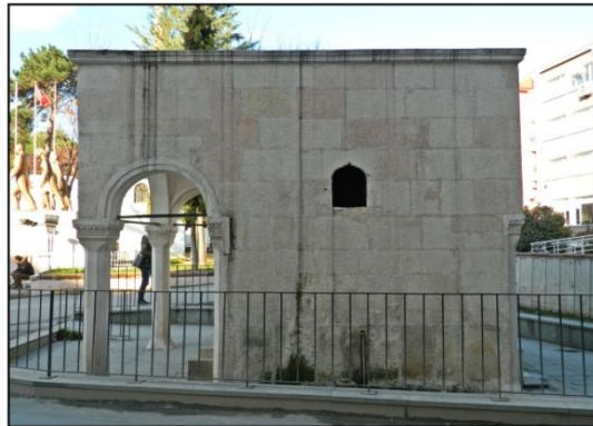
Şekil 2.29. Çeşmenin Doğu cephesi (Özge Tokur, 2019)
