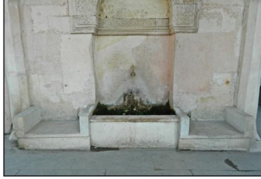
Şekil 2.17. Çeşmenin Güney cephesindeki lülesi, kurnası ve iki oturma sekisi (Özge Tokur, 2019)
