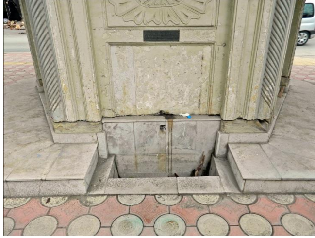
Şekil 2.98. Hüseyin Bey Çeşmesi E cephesi kurnası (Özge Tokur, 2019)
