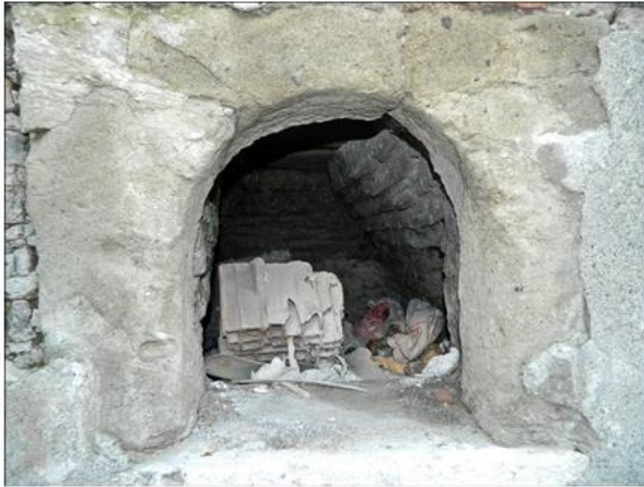
Şekil 2.65. Çeşmenin su haznesine bakan penceresi (Özge Tokur, 2018)
