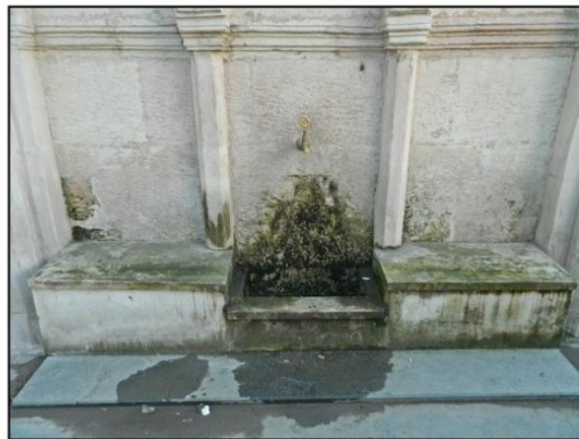
Şekil 2.19. Çeşmenin Kuzey cephesindeki lülesi, kurnası ve iki oturma sekisi (Özge Tokur, 2019)
