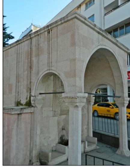
Şekil 2.21. Sütunların arasında bulunan demir gergiler (Özge Tokur, 2019)
