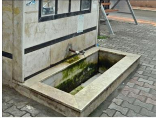
Şekil 2.147. Aynalı Çeşme'de oluşan yosunlanma (Özge Tokur, 2019)
