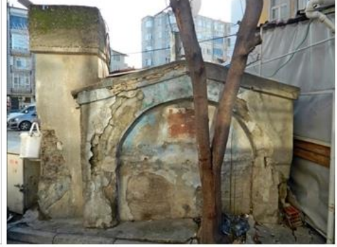
Şekil 2.64. Taşlı Çeşme genel görünüm (Özge Tokur, 2019)
