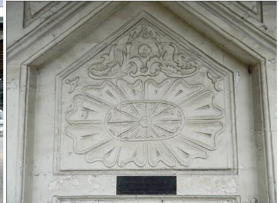
Şekil 2.97. E cephesi bezeme detayı (Özge Tokur, 2019)
