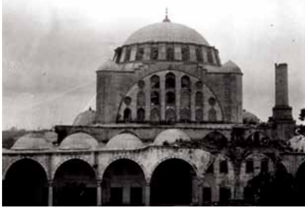
Fotoğraf 4. 1894 depreminin ardından Mihrimah Camii'ndeki yıkım.
