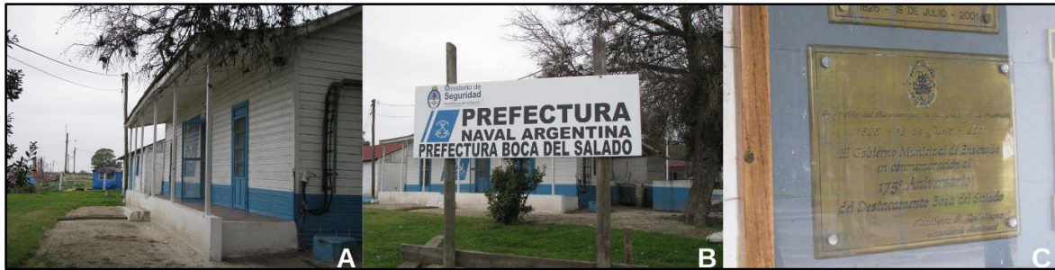
Fotografía 18: A) y B) Edificio de la Prefectura Naval Argentina en la desembocadura del río Salado, 2016 y C) placa en edificio anterior, donde se menciona el año de creación, 2016. Fuente: archivo personal de la autora.
