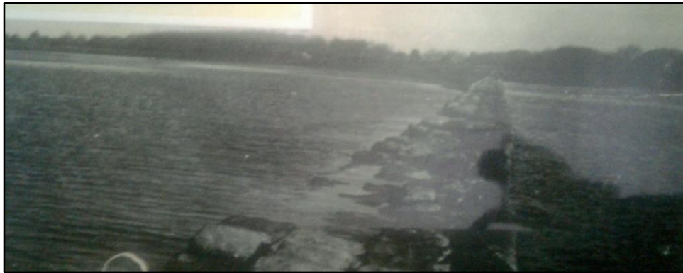
Fotografía 10: escollera construida en 1952. Fuente: Museo Histórico de Atalaya.
