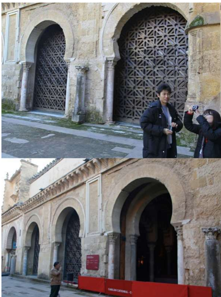
Ilustración 6. Vano del muro norte con la celosía de Rafael de la Hoz (antes de 2017) y tras la retirada de la misma. Imágenes El País/ Cordópolis. Con permiso para su publicación en erph.
