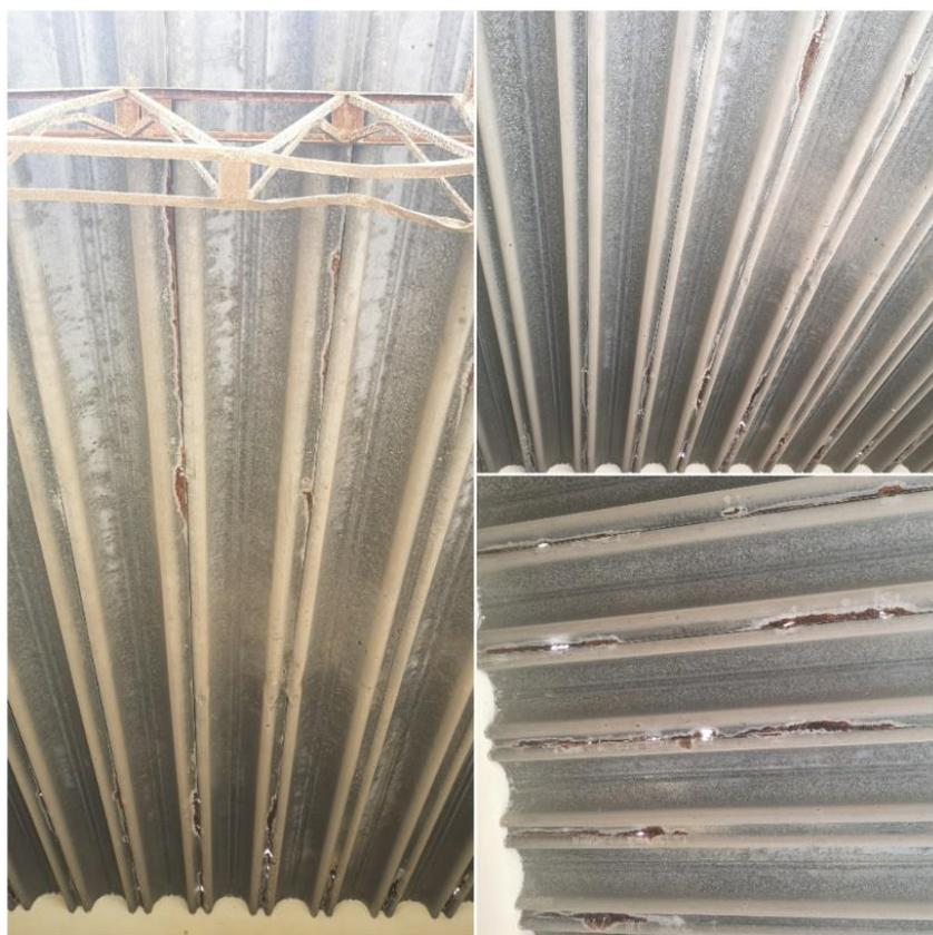
**Figura 16** | Telhado em estado de corrosão
