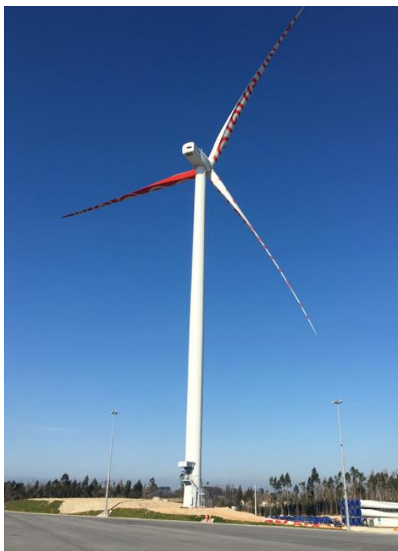
Figura 17 – Imagem do aerogerador eólico da empresa Ria Blades
