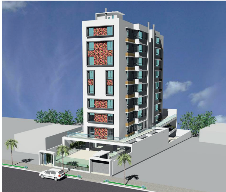
Figura 10: Edifício residencial. Fonte: Material enviado pelo cliente
