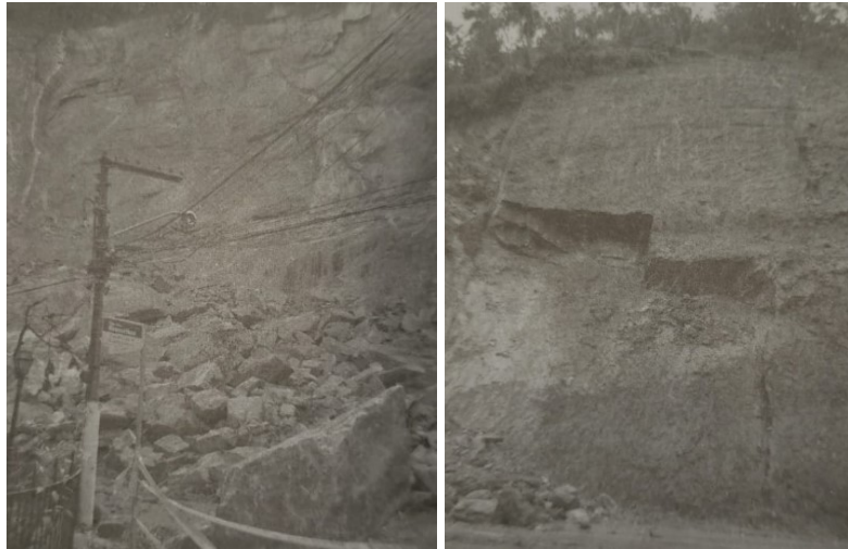
Figura 3 - Exemplos de ruptura por queda
