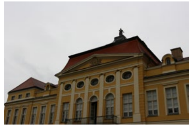
Fig. 1 - Vista geral da fachada do Palácio Rogalin.
