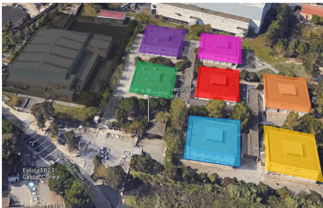
Figura 8. Planta da Escola Secundária Arco Íris da Portela, dividida por cores, representantes dos vários pavilhões. Fonte: Google Maps , 2019.
