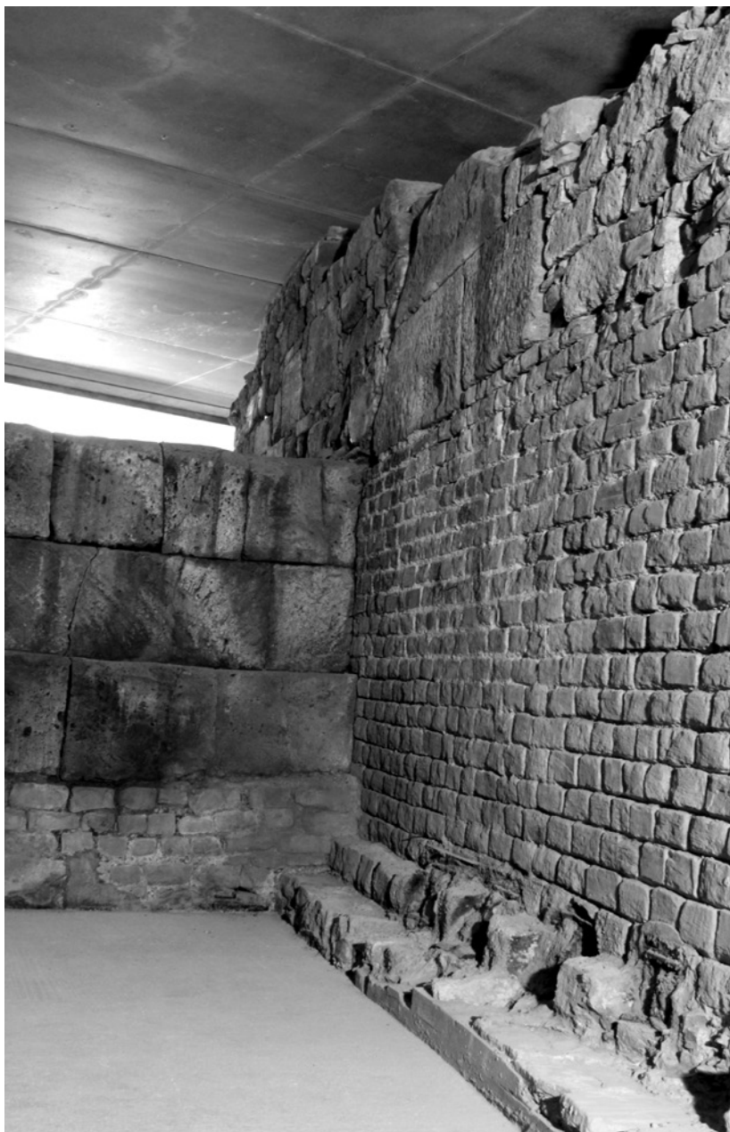
10 Köln. Römisches Hafentor mit Kanalauslass im unterirdischen Besucher- raum am Kurt-Hackenbergs-Platz. Der Rohbau wurde anlässlich des Baus der Nord-Süd Stadtbahn fertig gestellt und 2010 provisorisch geschlossen
