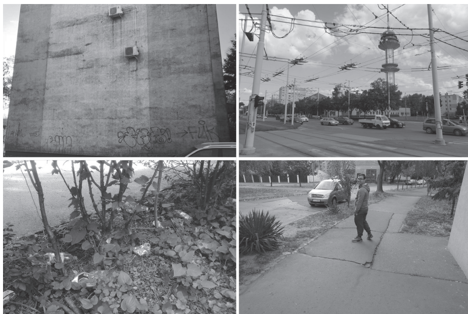
3. a-d) ábra Vizuális konfliktusok: a) penészes, összefirkált fal; b) légvezeték, forgalom (zaj); c) szemét; d) feltöredezett járda (fotó KARANCSI Z.) Figure 3 a-d) Visual conflicts: a) rusty, graffiti-covered wall; b) powerlines, traffic (noise); c) rubbish; d) damaged sidewalk (photo KARANCSI, Z.)
