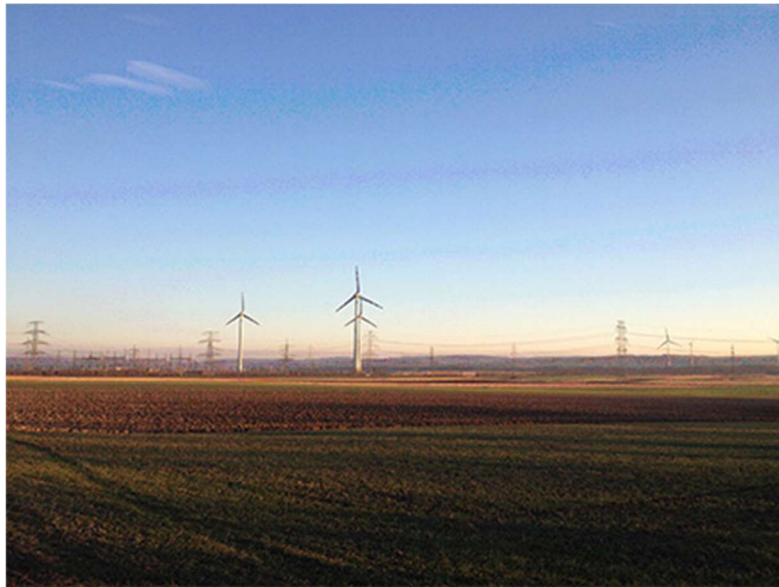
21. ábra Szélturbinák Burgenlandban (szerzők saját felvétele) Figure 21. Wind turbines in Burgenland (authors' photo)
