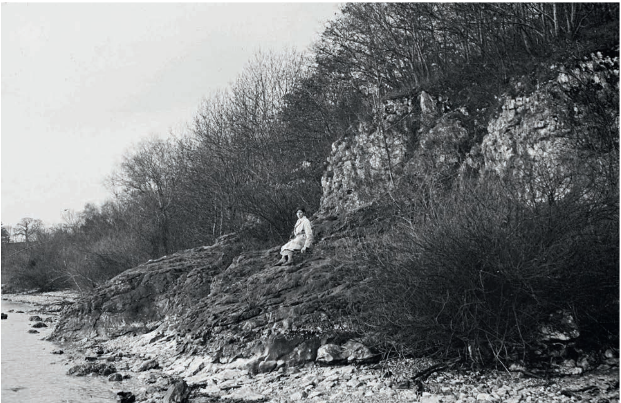
Abb. 20: Vaumarcus NE. Strandzone mit Abbauspuren in der Nähe des grossen römischen Steinbruchs von La Lance («Urgonien», Vallorbe-Formation), Zustand 1934.
