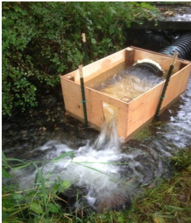
Figure 31. Exemple de passe migratoire au niveau d'un barrage de castor (Beaver Institute- https://www.beaverinstitute.org/ )
