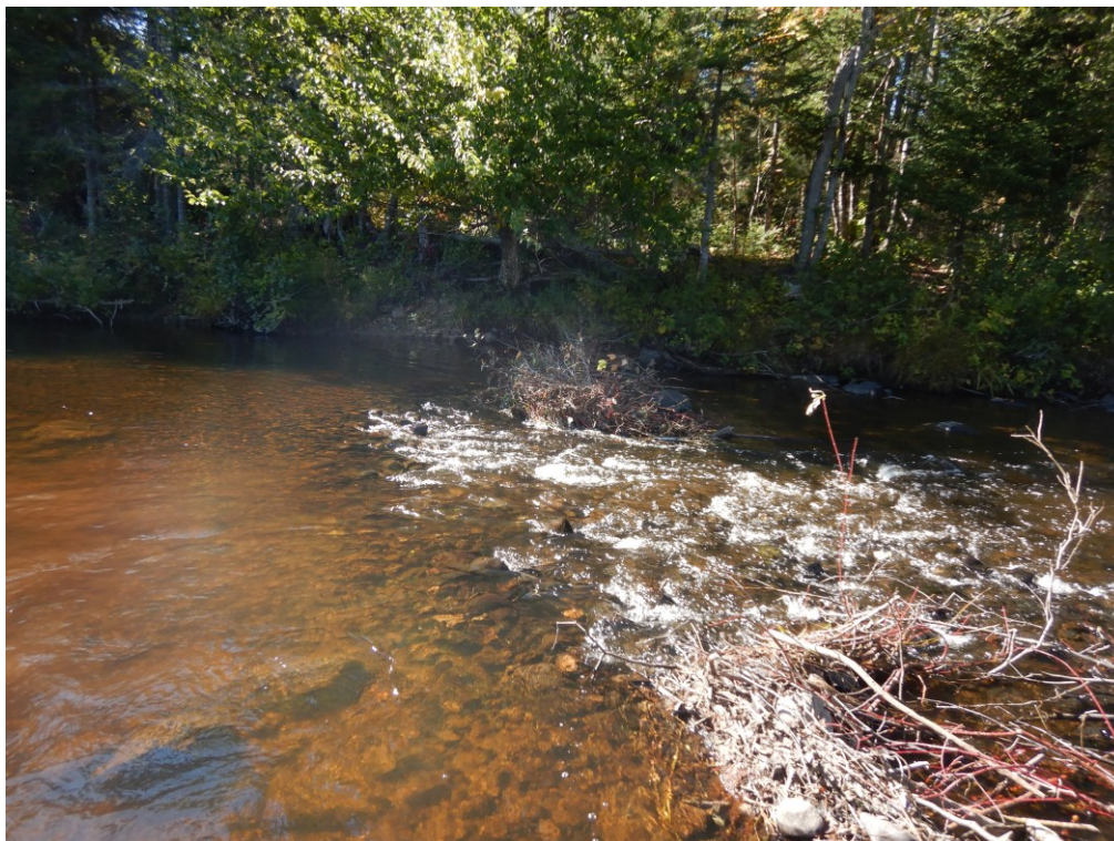
Photo 3. Barrage aval en construction au site du barrage 2. Vue vers la berge gauche.
