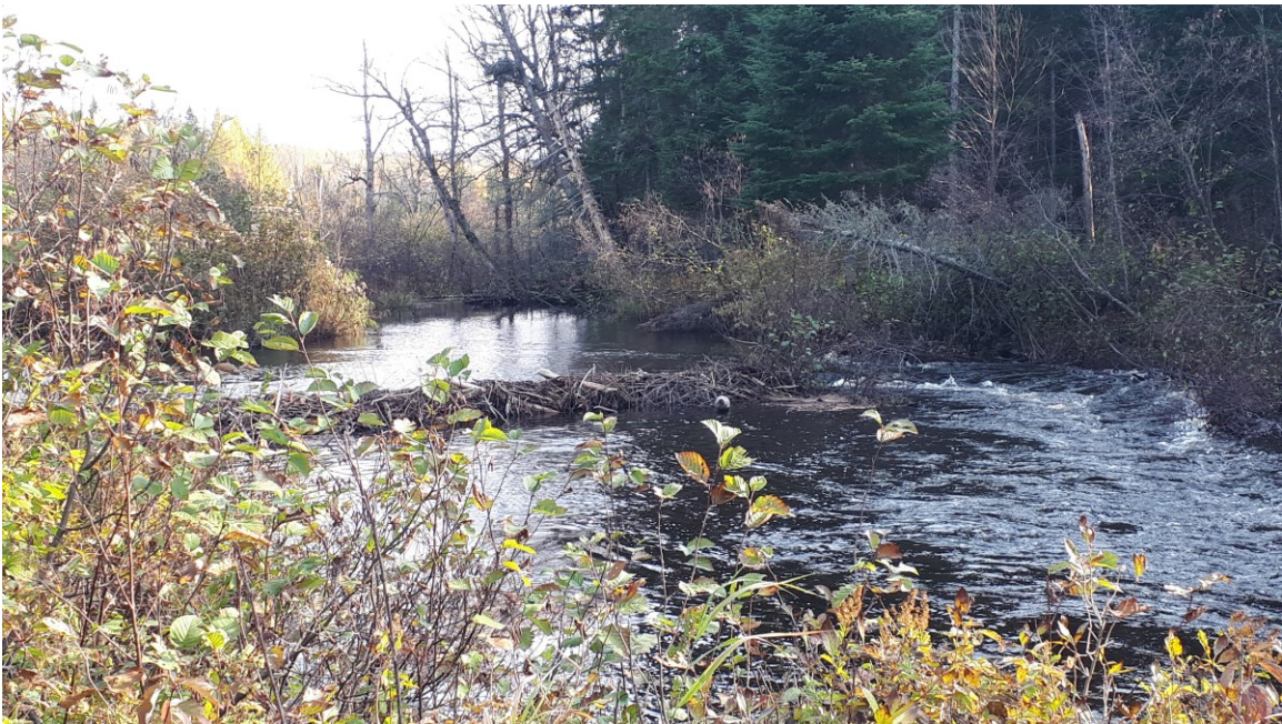
Photo 10. Barrage nord du site de barrage 3 le lendemain de la crue du 18 octobre 2020. Vue vers la berge gauche.
