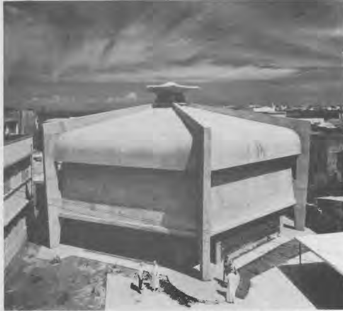
Desde el patio interior se aprecia la estructura y las formas usadas en esta edificación.
