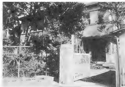
写真10-41 農業簿記研究施設正面玄関
