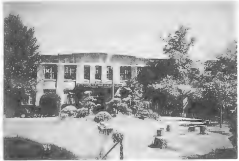
写真10-47 水産実験所本館
