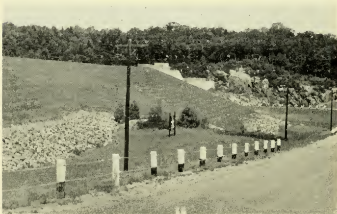
Blackwater dam, Webster, N. H.
