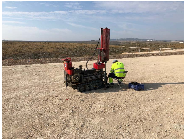
Foto 2. Ensayo en obra
