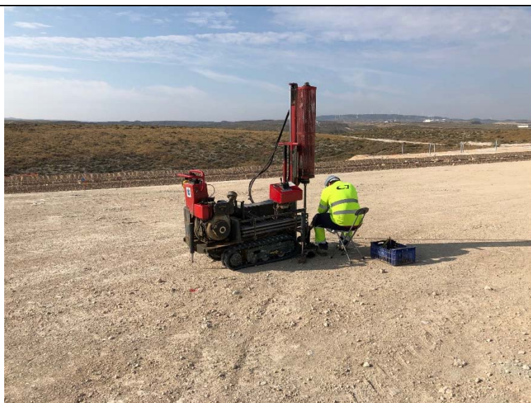
Foto 2. Ensayo en obra
