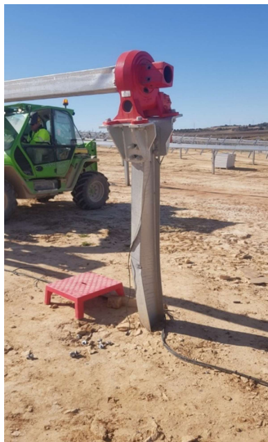
Foto 3. Detalle Motorreductora
