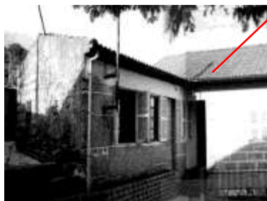
A fachada ainda mantém as dimensões originais...
