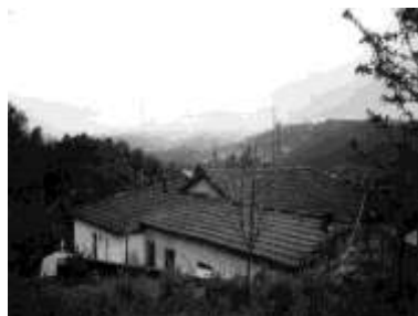
Vista da Oficina e da habitação que a ela se uniu
