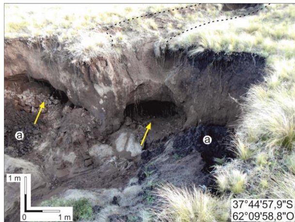
Figura 6.24. Pipping (flechas amarillas) en la Incisión Fluvial correspondiente a la de la Figura 6.22 (Valle de las Grutas, subzona 2). a: material caído. Línea de trazos: nótese el carácter incipiente de la canalización aguas arriba de la cárcava. El lecho del tramo inferior es un material más arcilloso, que dificulta la infiltración y la incisión, y favorece el pipping en el material superior más permeable. Foto: Juan M. Susena.
