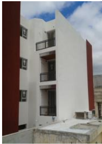
Fachada NE. Patio Interno
