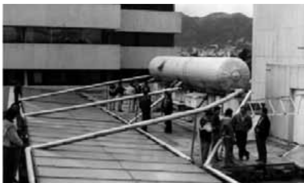
Figura 5. Calentador solar de la cafetería de la antigua Empresa de Energía de Bogotá (EEB)
