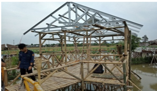
Gambar 4. Pembangunan Rangka Baja PLTS
