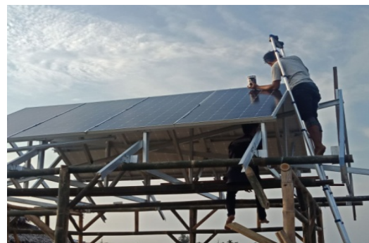
Gambar 5. Pemasangan Panel Surya
