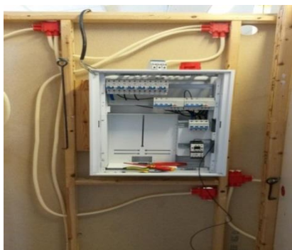
Bilde 1. Montering av sikringsskap i inngangspartiet ved modul 1.
