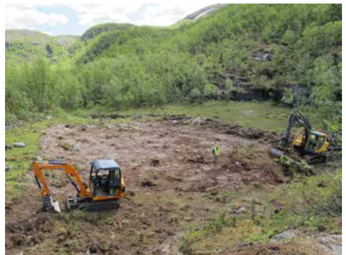
Figur 12 Maskinell avtorving nesten fullført på Felt B. Foto mot S. 29.06.2012
