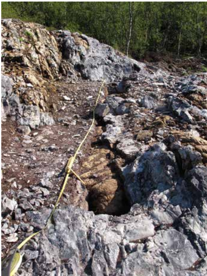
Figur 94 A2540 etter sjakt er ferdig gravd. Foto mot Ø. 20.08.2013.
