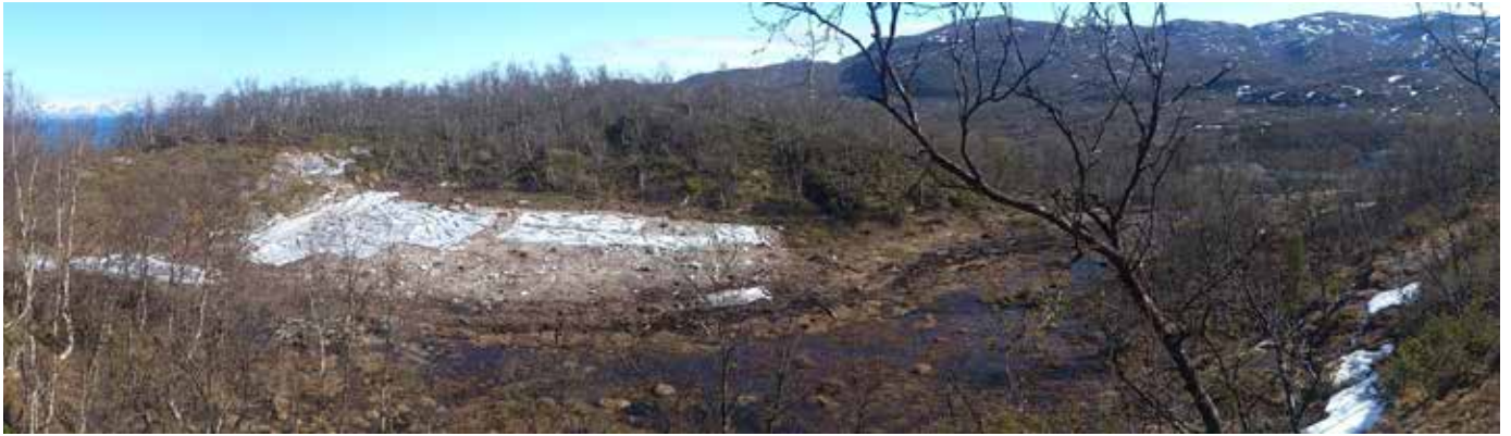
Figur 15 Utgravningsområdet i mai 2013. Deler av Felt B er dekket med vegduk. Skogen er ryddet på Brudd 1, til venstre for Felt B, men er foreløpig ikke avtorvet. Felt C skimtes så vidt i høyre bildekant. Nedenfor Felt B er den lille myra omdannet til våtmark, og det renner store mengder vann herfra, gjennom søkket i terrenget mellom Felt B og Felt C, og forbi den nordøstlige delen av Felt C. 22.05.2013
