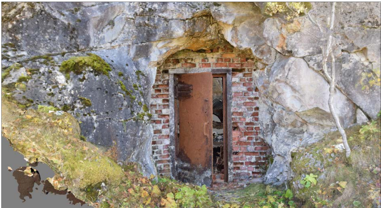
Figur 98. Inngangen til ammunisjonslageret. 3D-render basert på fotogrammetrimodellen. Døren måler 177 x 77 cm. Figure 98. Entrance to ammunition depot. 3D-rendering based on fotogrammetric model. The door measures 177 x 77 cm.
