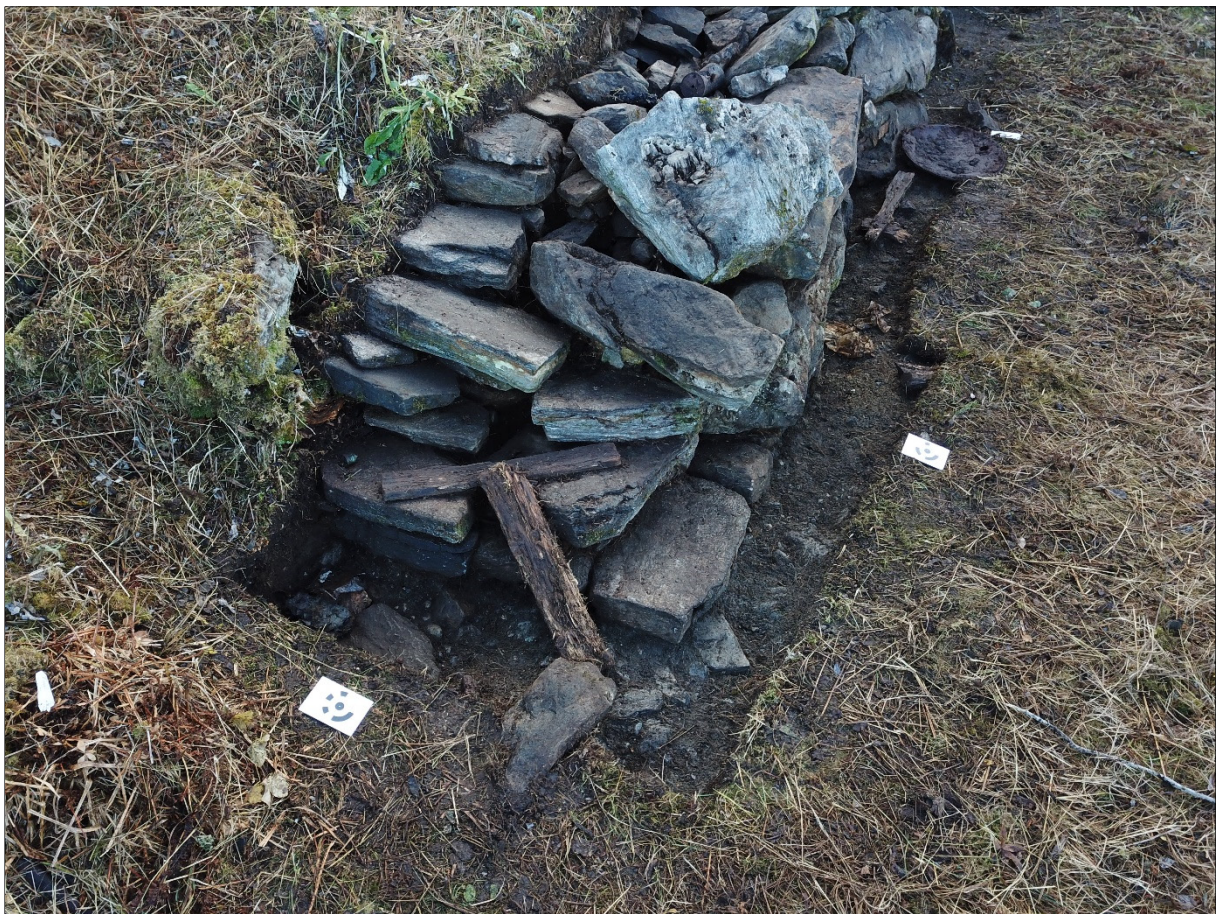
Figur 64. Den nordlige enden av A1984 sett mot sør. Steinhellene midt i fotografiet har antagelig fungert som fundament for en trapp. Trevirket kan være rester etter selve trappen.
