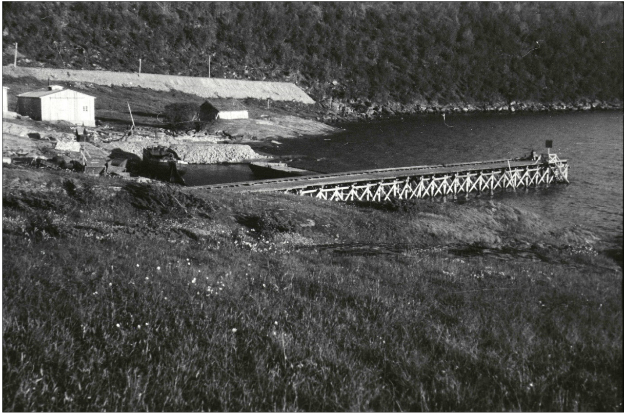
Figur 15. Kaianlegget i Kalvik (253). I bakgrunnen ses den tyske verkstedbygningen (Werkstatt) og Bjarne Hansens naust. Helt bakerst i bildet ligger fyllmassene fra tunellbyggingen. Foto: Johannes Martin Hennig.
