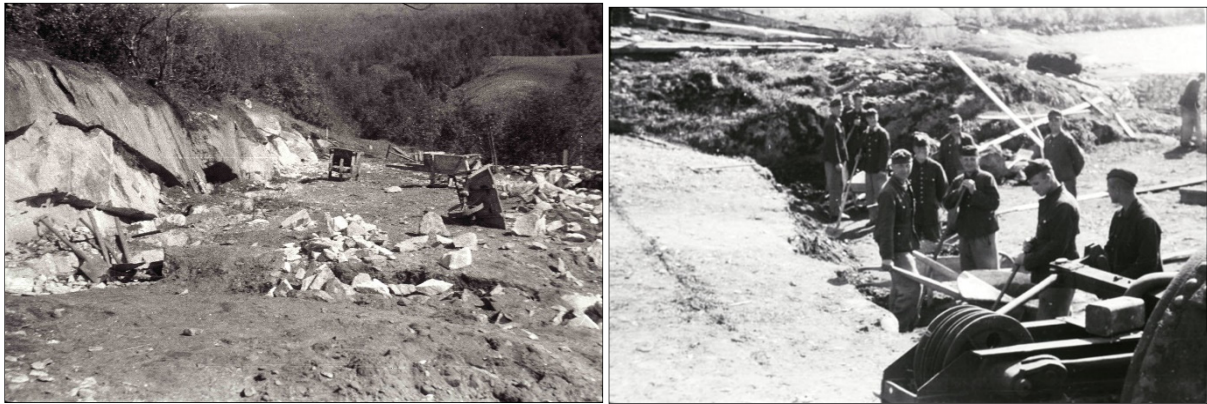
Figur 10: Den østlige vaktbrakken (venstre) og tankanlegg under bygging i Kalvik. Foto: Johannes Martin Hennig. Figure 10. The eastern guard barrack (left) and the tank farm under construction.
