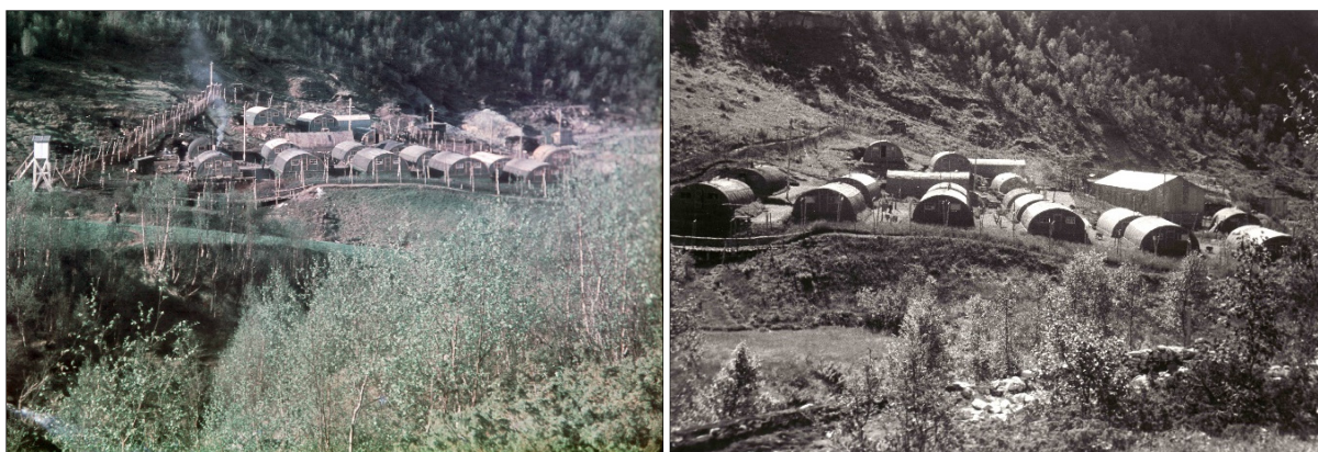
Figur 9. Spisebrakken ble oppført under Hennigs opphold i Kalvik. Venstre bilde viser leiren før denne bygning var bygd, til høyre ved ferdigstilling. Foto: Johannes Martin Hennig.
