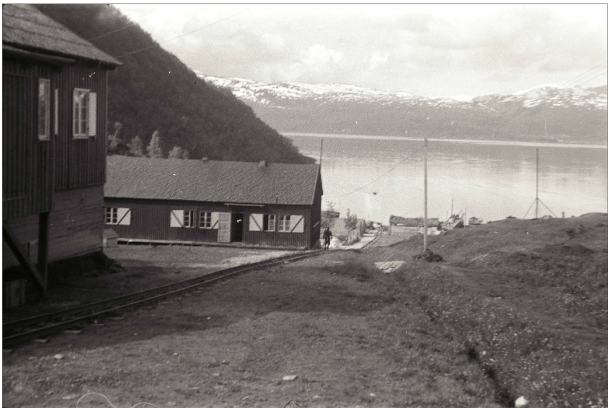
Figur 16. Deler av den tyske forlegningen. I forgrunnen ses skinnegangen. Til venstre ser man deler av den tyske spisebrakken («Wirtschaftsbaracke») og nedenfor OTs kontor- og vaktbrakke (203). Bildet er tatt mot sørvest. Foto: Johannes Martin Hennig.
